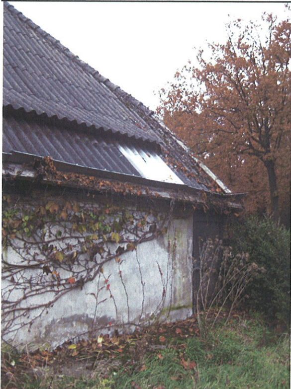
Foto aansluiting zijgevel op achtergevel
