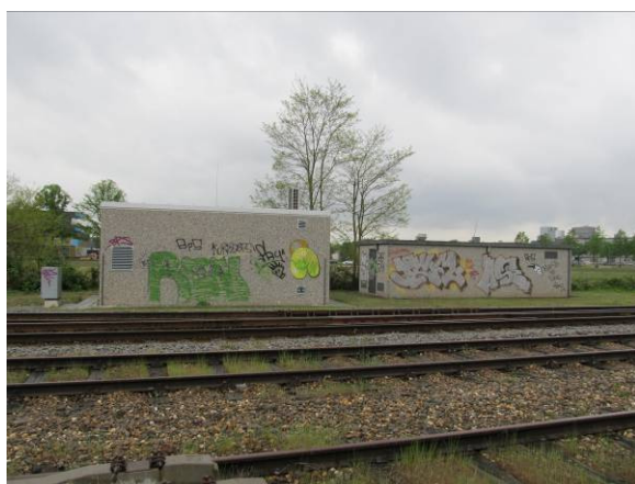
Figuur 6. Trafohuisjes langs het spoor
