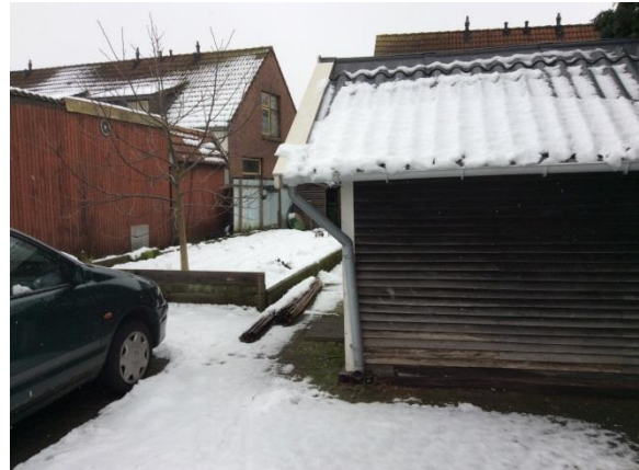
Figuur 9: Overzichtsfoto bebouwing
