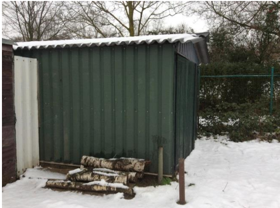
Figuur 8: Overzichtsfoto bebouwing
