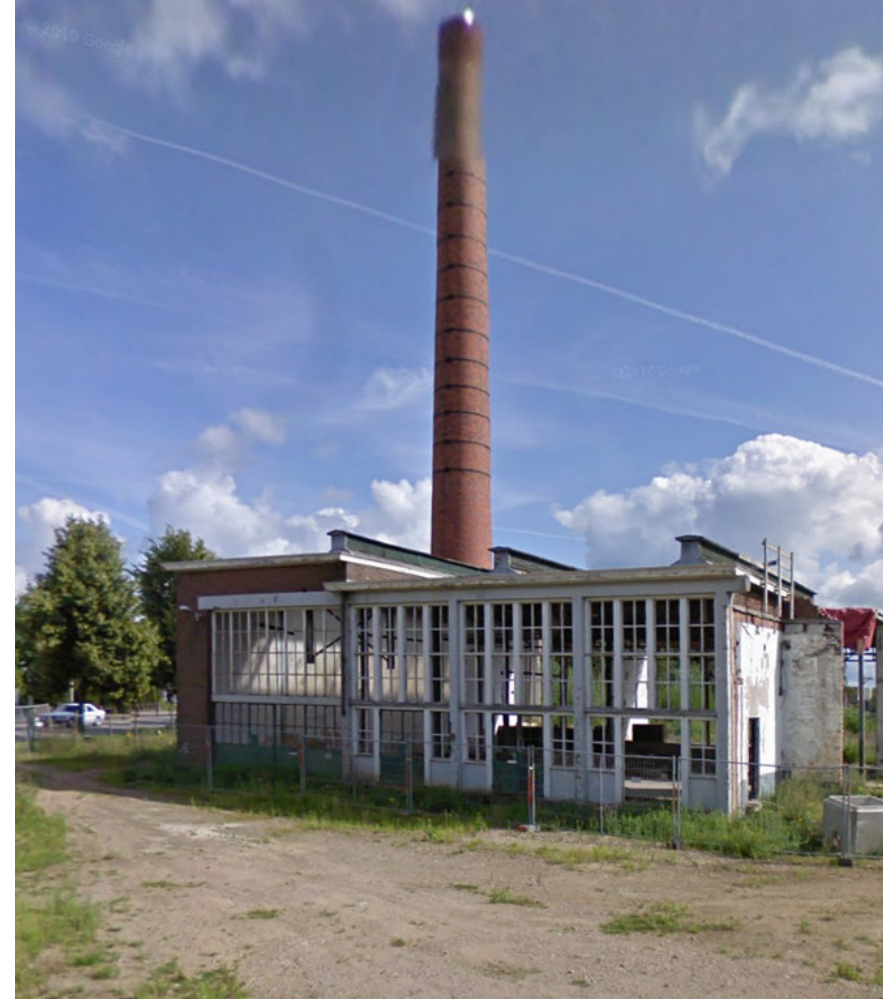
Gemeentelijk monument, het voormalige ketelhuis met schoorsteen
