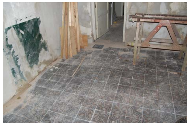
Tegelvloer in de voormalige gelagkamer.
