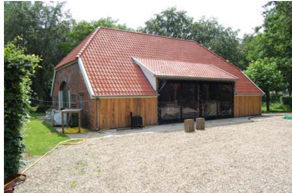
De zijgevel van de doorrijschuur is vernieuwd en voorzien van grote openingen.
