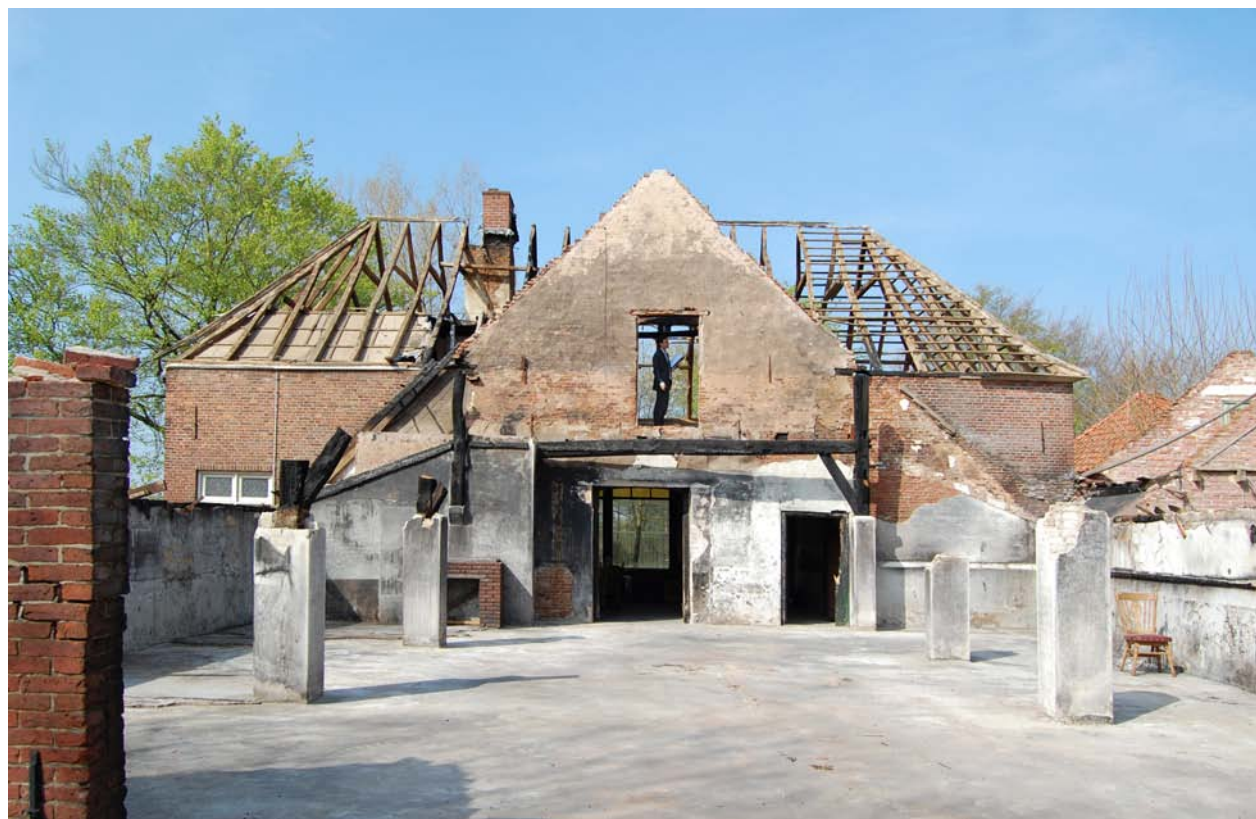
Overzicht van het bedrijfsgebouwtje in de richting van de brandmuur.
