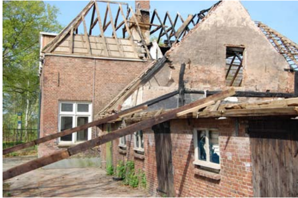
Linker zijgevel van het bedrijfsgedeelte en de achtergevel van het rechter deel van de woning.
