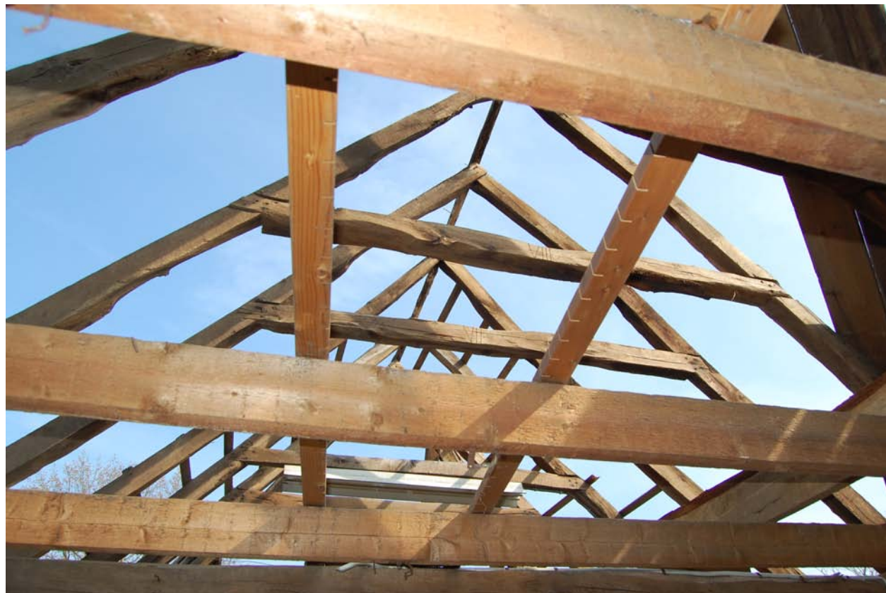
Kapconstructie opgebouwd uit eiken daksporen.
