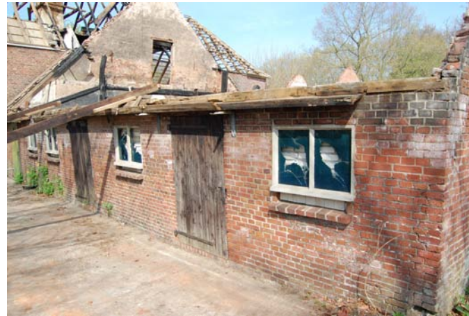
Linker zijgevel van het bedrijfsgedeelte, verlengd in het begin van de vorige eeuw en verhoogd na 1945.
