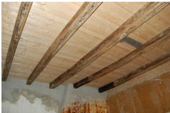
Zolderbalklaag in de opkamer.
