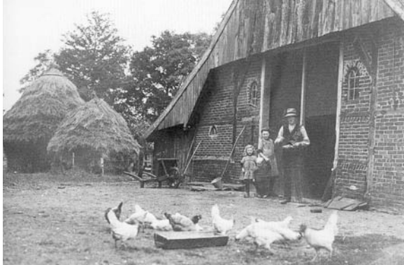
Achtergevel van een oude boerderij met een traditioneel ingericht erf. De achtergevel is nog uitgevoerd in vakwerk dat met metselwerk gevuld is. De topgevel heeft verticaal beschot.
