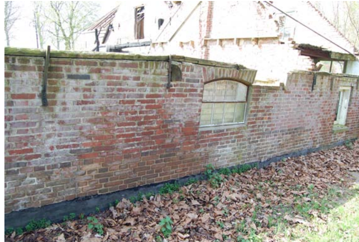
Linker zijgevel van de in 1922 gebouwde (vaalt)stal.
