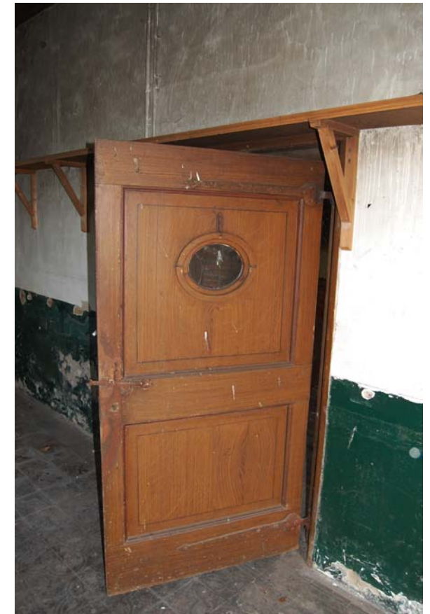
Deur van de heerd, afgehangen met zware duimgehengen en voorzien van een klink.
