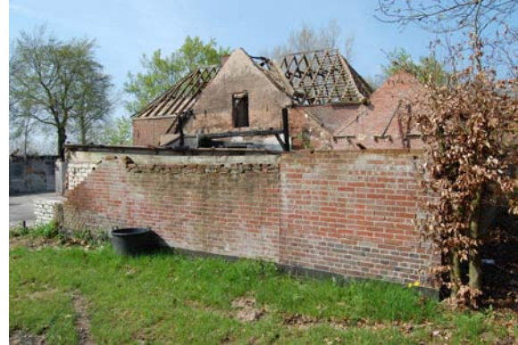
Achterzijde van de aangebouwde stal.
