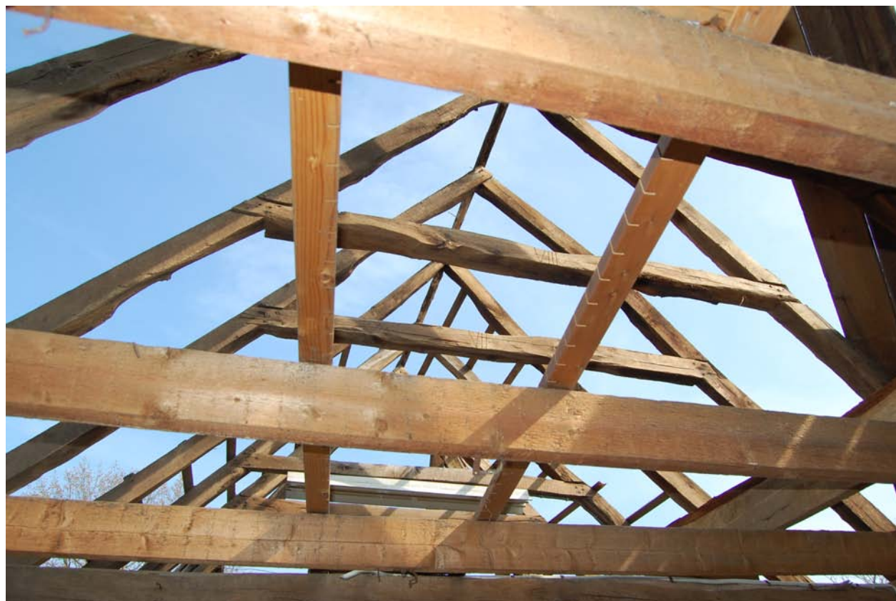
Kapconstructie opgebouwd uit eiken daksporen.
