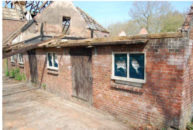
Linker zijgevel van het bedrijfsgedeelte, verlengd in het begin van de vorige eeuw en verhoogd na 1945.
