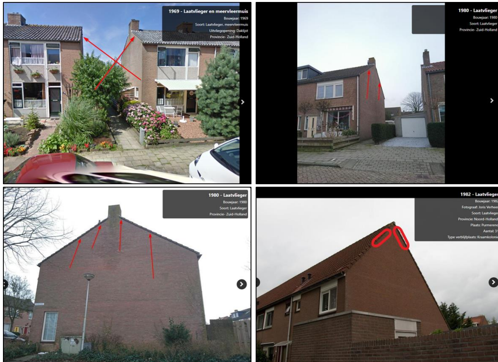
Figuur 4 Aangetroffen vaste rust- en verblijfplaatsen. Van veraf lijken er zelfs geen openingen aanwezig te zijn. De kantpannen dienen als, eis voor een vleermuis verblijfplaats, aan te sluiten op de kopgevel (bron: www.gebouwbewonend.nl )
