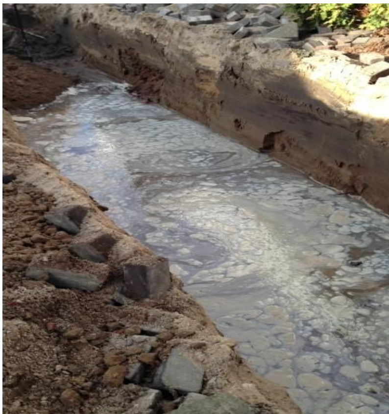
Afbeelding 2: Wateroverlast in wp 1 als gevolg van gesprongen leiding.
