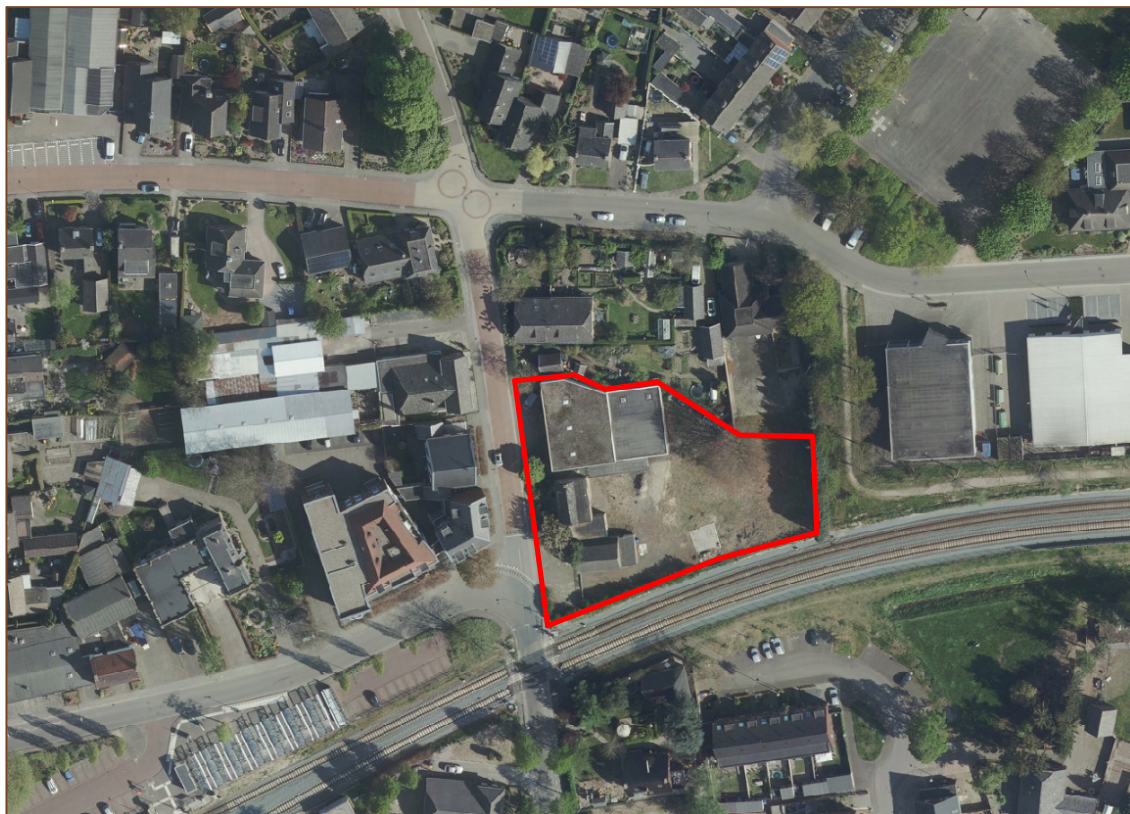
Figuur 2. Luchtfoto van het plangebied (rood). Bron: Provincie Gelderland (2018).
