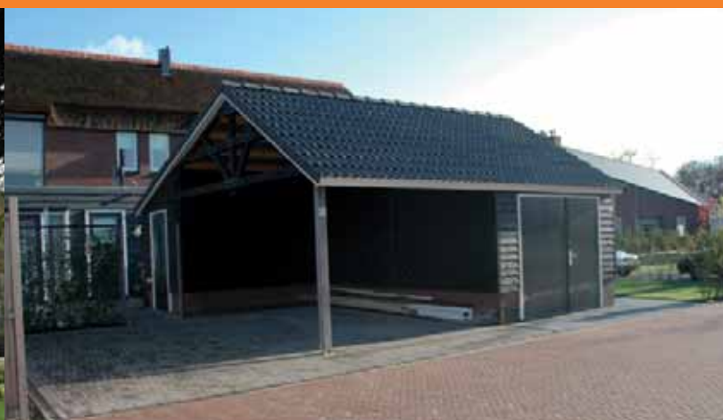
Carport gecombineerd met schuurtjes
