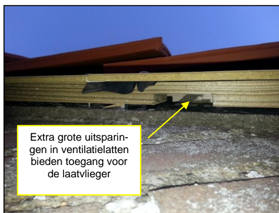
Figuur 18. Vlemuisvriendelijke afwerking dakrand
