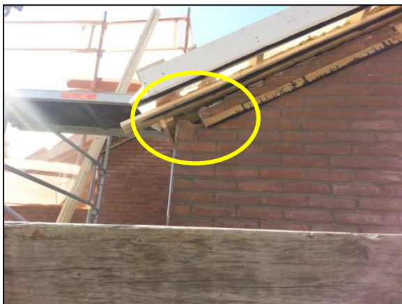
Figuur 20. Nis voor gierzwaluw, aangebracht door het verwijderen van één steen aan het einde van het buitenblad.
