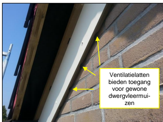
Figuur 17. Vlemuisvriendelijke afwerking dakrand.
