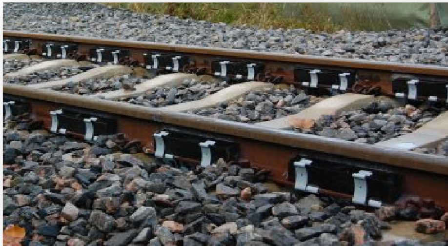
Figuur 6.2 Een voorbeeld van de bronmaatregel raildempers. Dit zijn de zwarte rubberen blokken die in dit geval tegen de rails worden geklemd.
