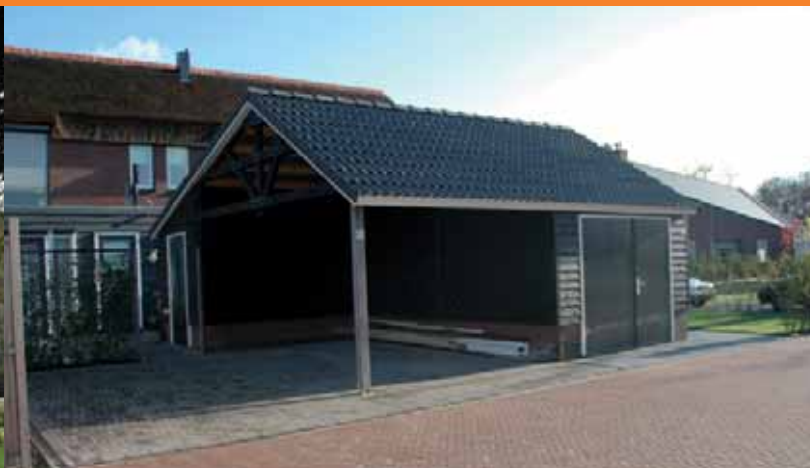
Carport gecombineerd met schuurtjes
