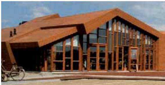
Lage goot en flauwe dakhelling
