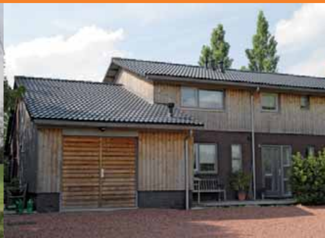
Naar voren stekende uitbouw bij rijwoning
