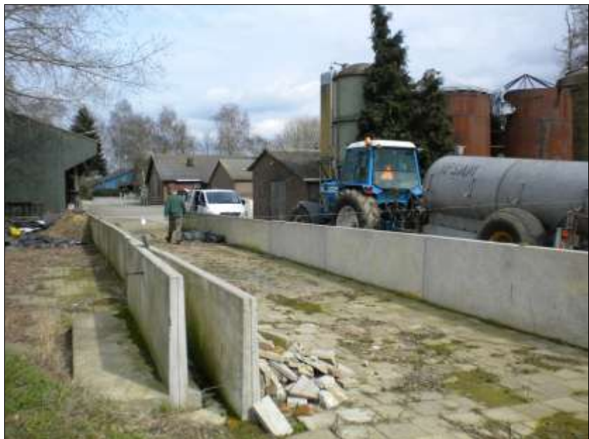
Figuur 15: Het erf met de kuilplaten en het silo-blok, gezien richting het noorden.
