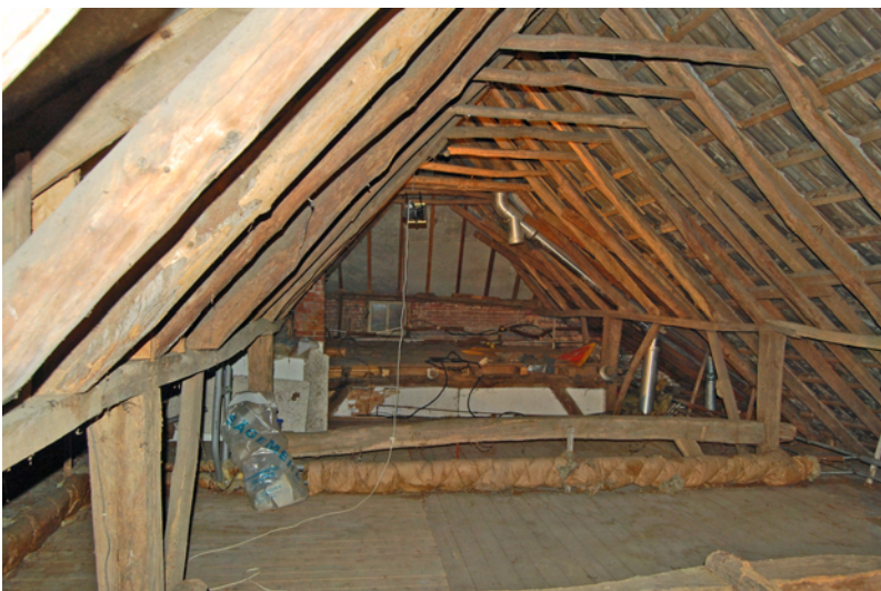
Overzicht van de gebintenstructuur op zolder in de richting van de voorgevel.
