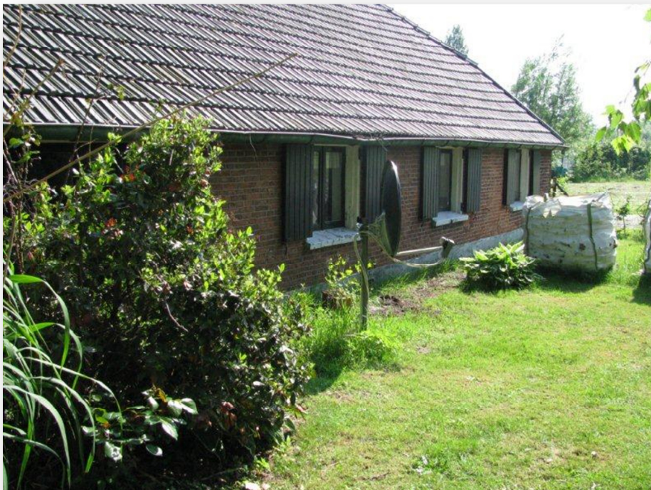
Bestaande westgevel, zicht op tuin met gazon en enkele sierheesters en grassen.
