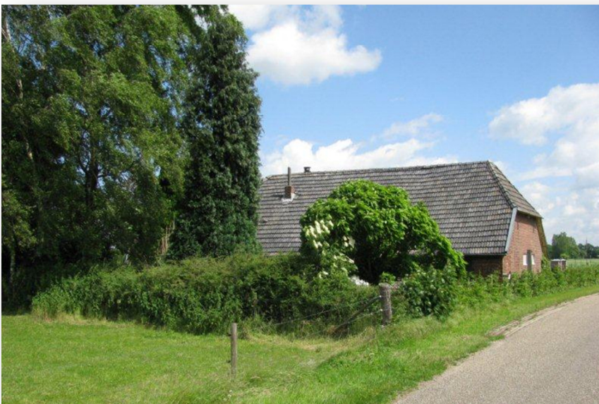
Zicht op de boerderij vanaf de Steverinkstraat (west).
