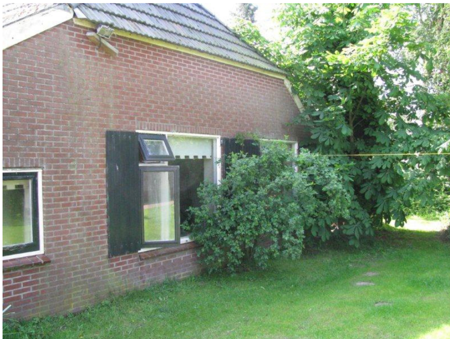
Bestaande noordgevel (met te vervangen niet cultuurhistorische raampartijen van jongere datum)
