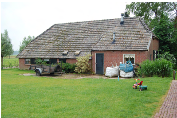
Linker zijgevel en voorgevel.
