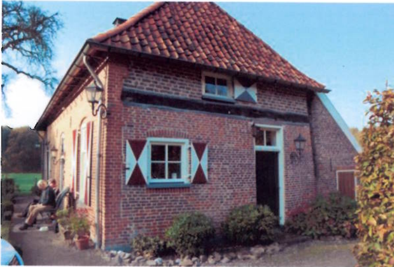
Oostgevel van het Pallandje met een in de zijgevel opgenomen ankerbalkgebint en rechts en interieur opgenomen hoekstijl met daarin de pengaten van verdwenen wandregels.
