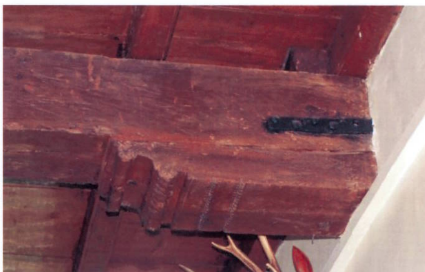
Sleutelstuk met een 16 de eeuwse profilering, aangebracht onder de enige bij de brand van 1934 bewaard gebleven balk (tweede balk vanaf het zuiden, tegen de achtergevel)
