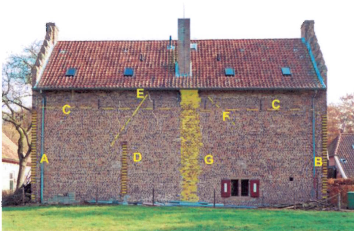
Achtergevel met in geel de in de tekst genoemde bouwsporen. A en B: vertanding aan de achterzijde van de kopgevels. C: horizontale bouwnaad. D: vertanding behorend bij verdwenen dwarsmuur. E en F: daklijnen behorend bij een aanbouw die na de wederopbouw hier gestaan heeft. G: later ingebroken rookkanaal behorend bij schouw in de kelder.
