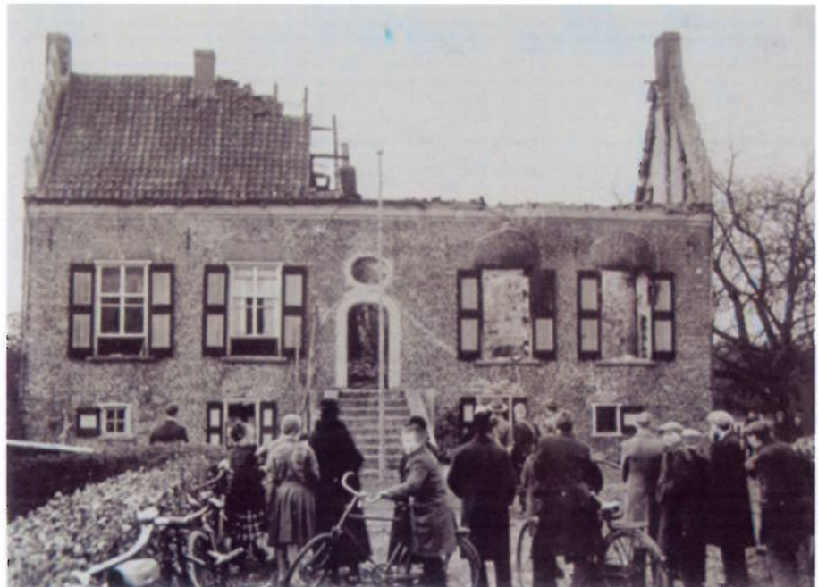
Foto waarschijnlijk gemaakt op 9 december 1934, de dag na de brand.
