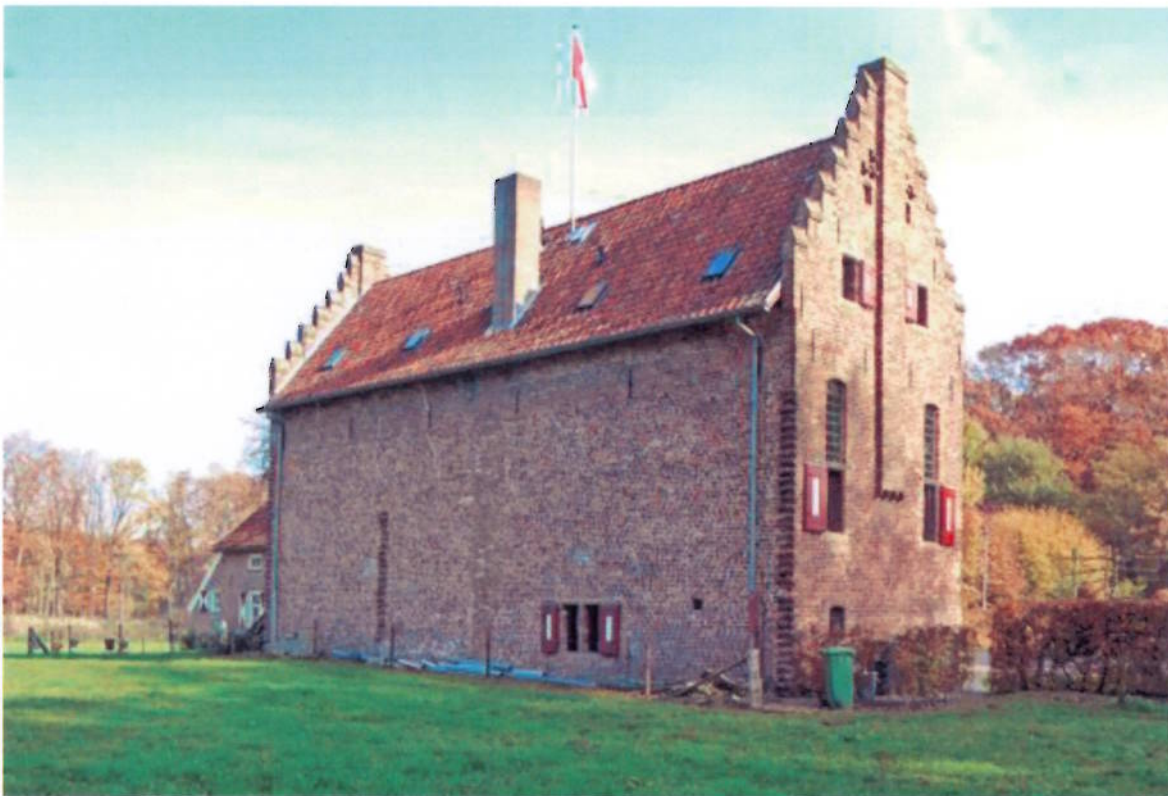
Het onderzochte huis, gezien vanaf het zuidwesten.
