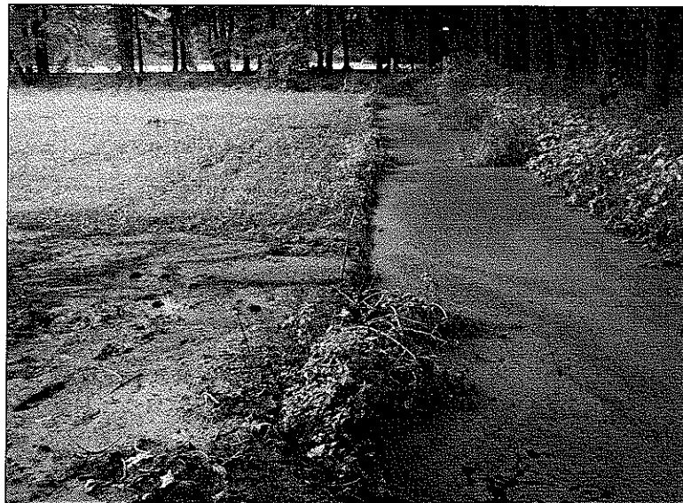
Foto 3 P2010-1950 Eindsituatie P-terrein d.d. 9-9-'10
