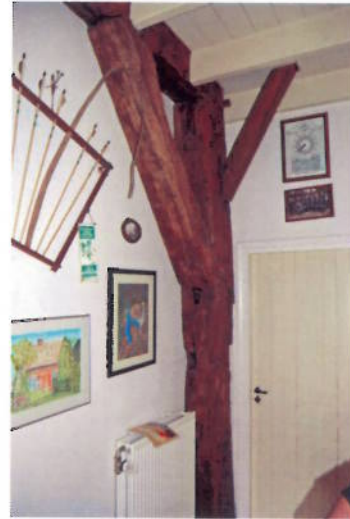
Oostgevel van het Pallandje met een in de zijgevel opgenomen ankerbalkgebint en rechts en interieur opgenomen hoekstijl met daarin de pengaten van verdwenen wandregels.
