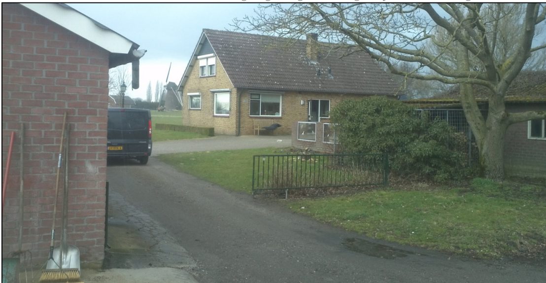
Centraal het bestaande woonhuis, met aan weerszijden de te handhaven bijgebouwen, gezien vanaf locatie nieuw te realiseren loods. Op de achtergrond de molen Bernadette.
