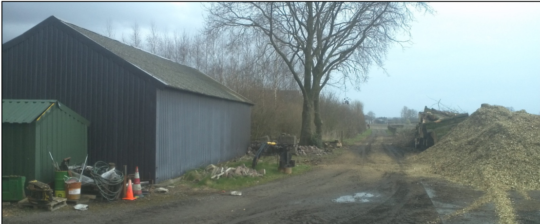
Links de te slopen loods, aan rechterzijde de locatie van de nieuwe loods. Centraal de bestaande toegangsweg richting Heyendaalseweg
