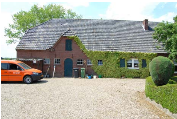
Linker zijgevel. Het dak is gedekt met gesmoorde muldenpannen en rondom is geen goot aangebracht.
