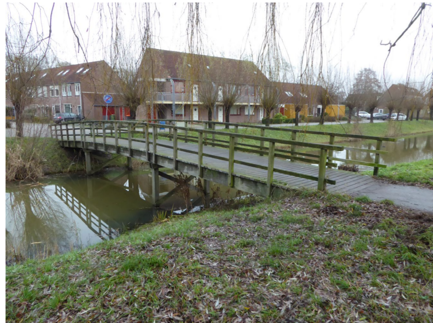
0017 - HOUTEN VOETGANGERS-, FIETSBRUG
