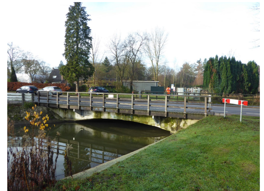
0022 - BETONNEN VERKEERSBRUG MET HOUTEN VOETPADEN
