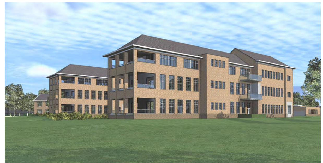
Figuur 4.28 de oude loggia's worden hersteld. Balkons worden toegevoegd ter plaatse van de beschadiging.
