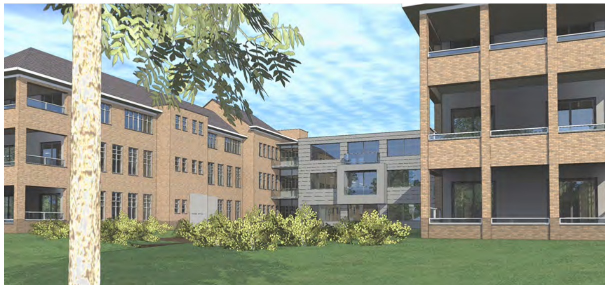
Figuur 4.30; het later aangebouwde tussenlid wordt verbouwt en zichtbaar gemaakt. Parkeren ligt verdiept tussen de blokken.
