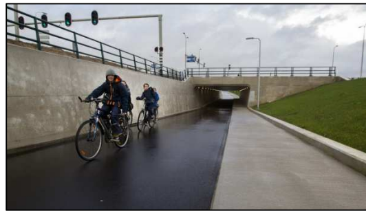
Foto 1: fietstunnel met eenzijdige rechte wand
