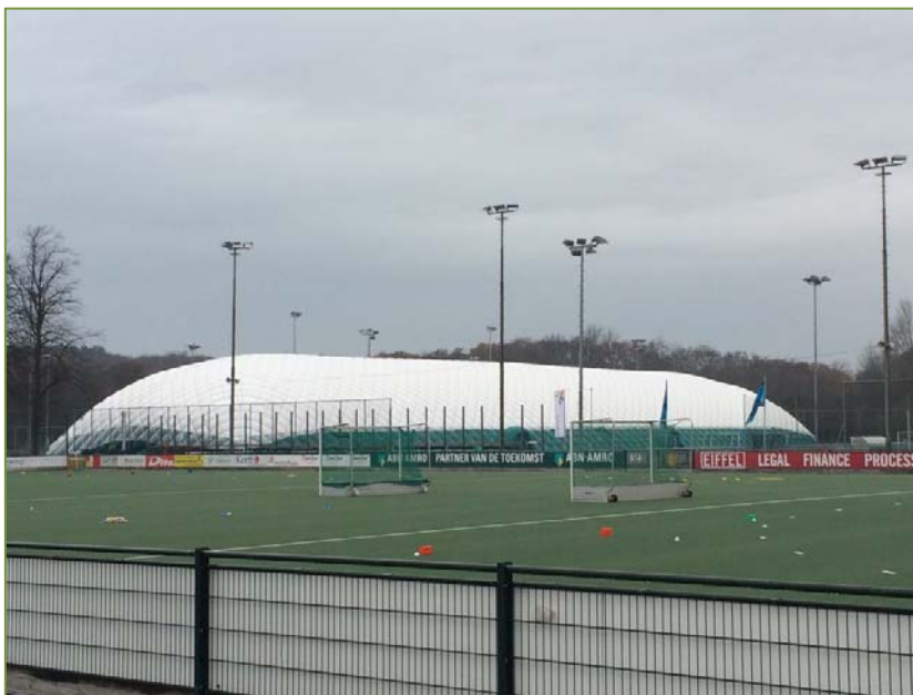
Figuur 4. Indruk en een voorbeeld van de Poly-Ned luchthal (Polyhal) die voor ogen staat (foto van Poly-Ned).
