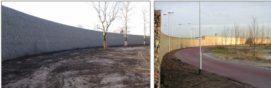
Figuur 3.3 Voorbeeld geluidsscherm schans-/ steenkorven
