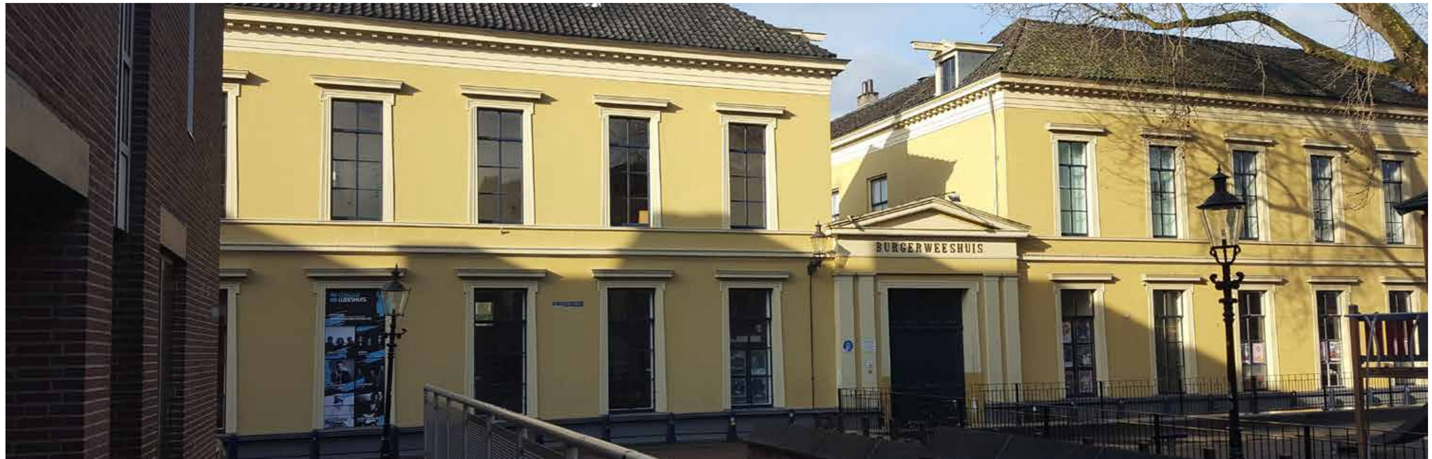
Nieuwe kleur gevel n.a.v. onderzoek? wanneer gewijzigd?
