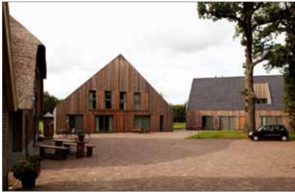
helder bouwvolume van één laag met kap
