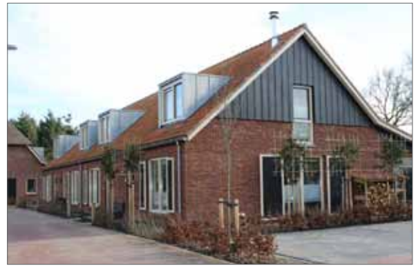
helder bouwvolume van één laag met kap
