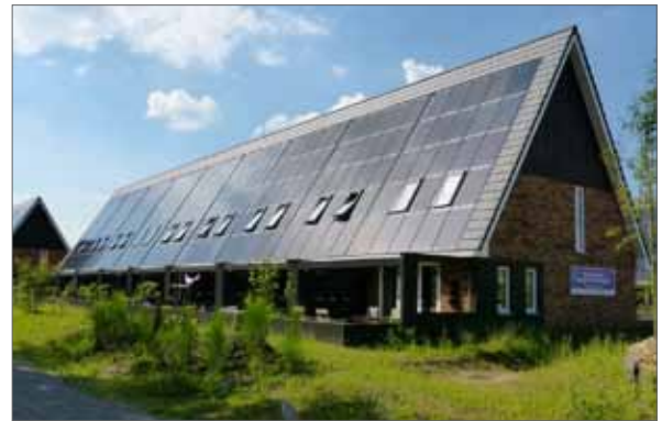
helder bouwvolume van één laag met kap
