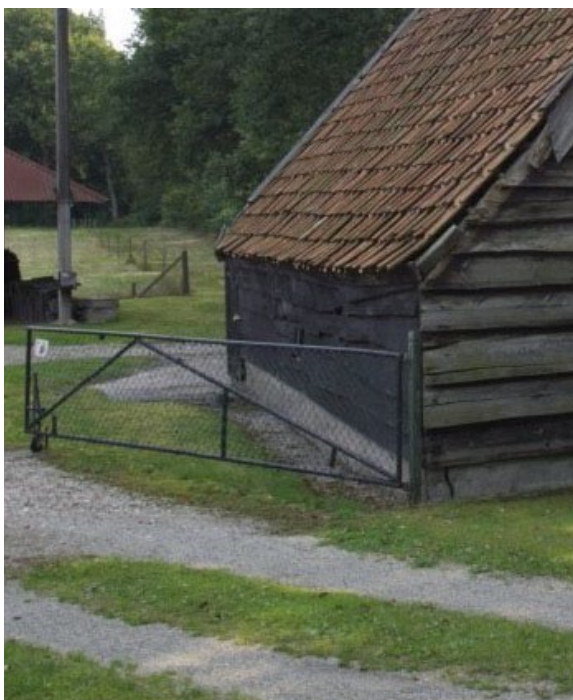
Afbeelding 67. Referentie halfverharding en houten gevels
