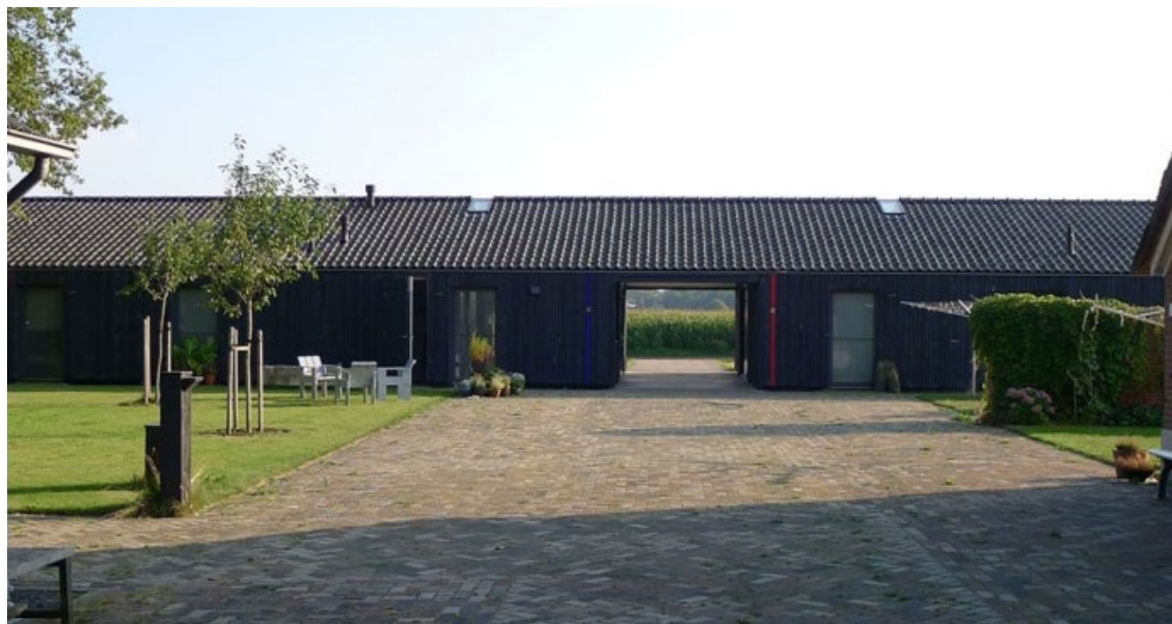
Afbeelding 64. Referentie goothoogte, detaillering daklijn en doorzicht naar het landschap met gebakken verharding en houten gevels
