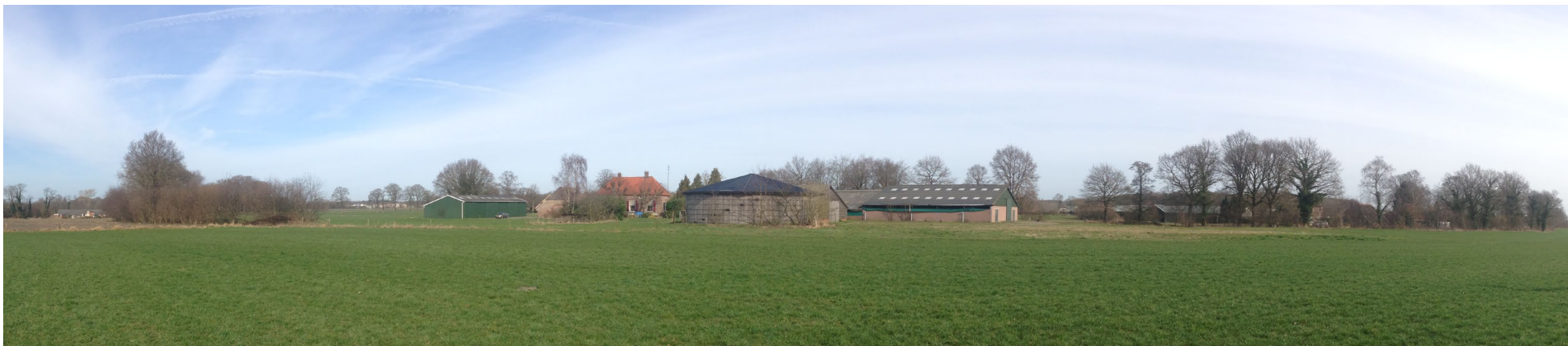
Afbeelding 14. Panorama bestaand erf: v.l.n.r. struweelrand op steilrand - doorkijk Oxersteeg - historische erf met erfbeplanting - landschapsontsiende bebouwing - bestaande houtwal langs Oxersteeg
