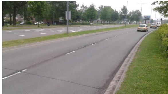
Foto 2: rafeling deklaag Holterweg
