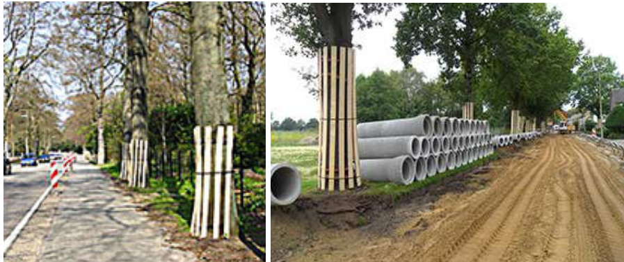
Figuur 2, voorbeeld bovengrondse boom beschermende maatregelen.
