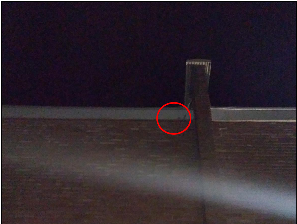
Locatie aan de zuidkant van het gebouw waar bij het tweede veldbezoek een invliegende gewone dwergvleermuis werd waargenomen.
