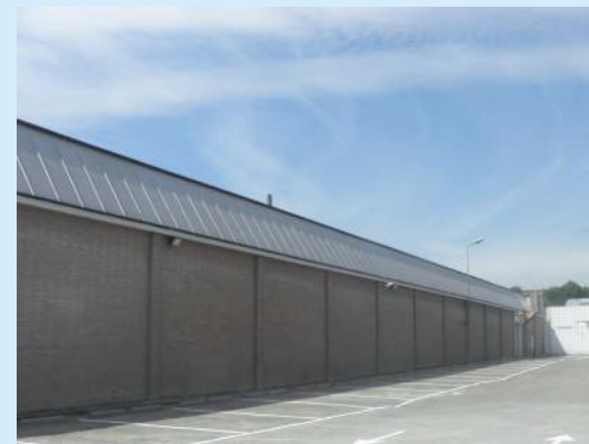
Hallen van de voormalige Aupingfabriek
