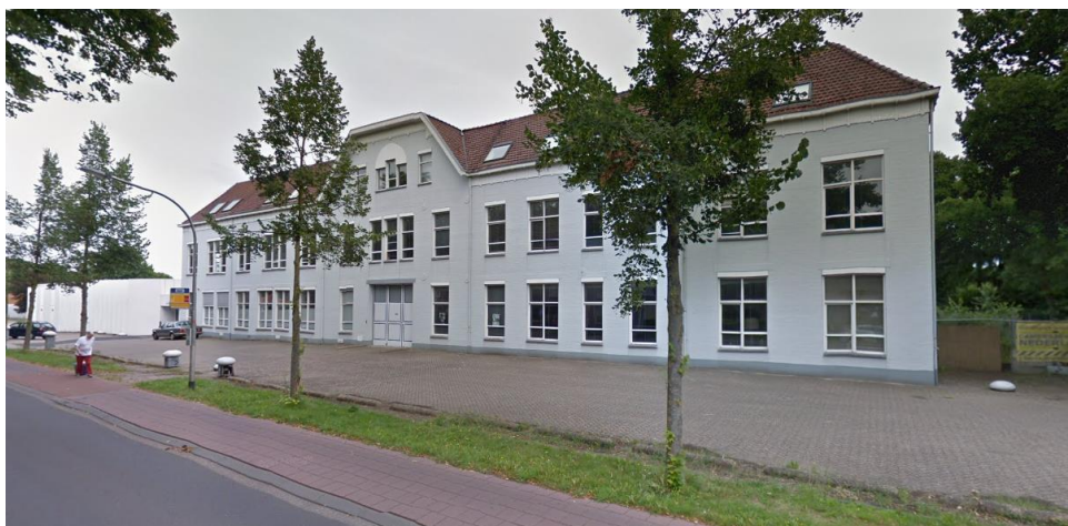
Foto bestaande kantoorpand aan Laan van Borgele (bron: Google Streetview)
