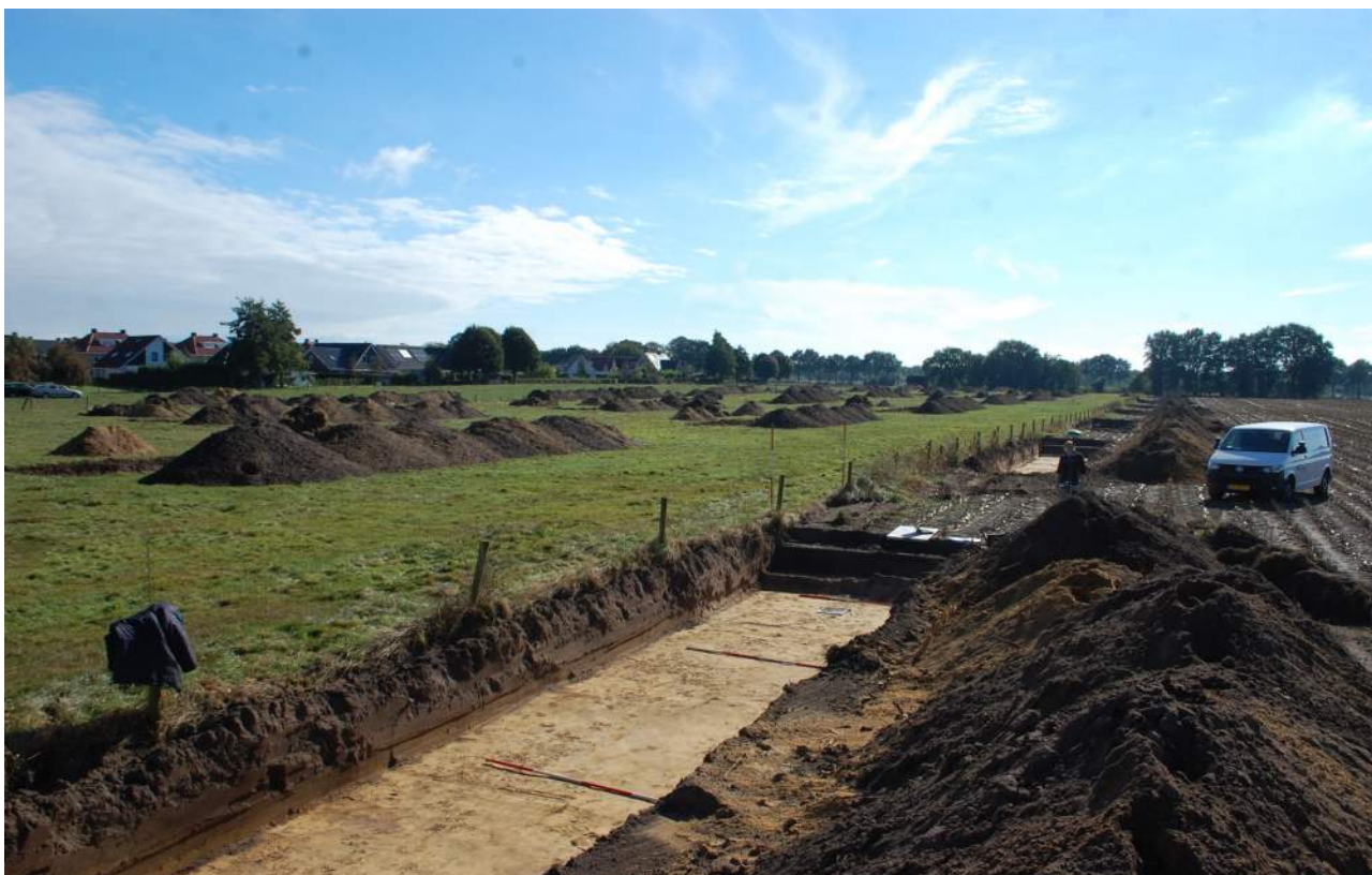
Afb. 1.1. De aanleg en documentatie van de proefsleuven.
