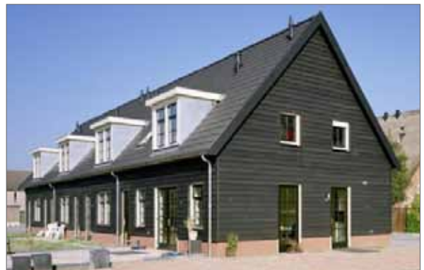
trasraam, roedes, lichte kozijnen, dakkapellen ondergeschikt door lichte kleur
