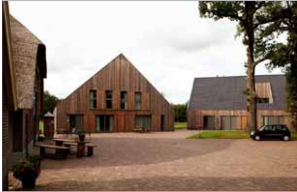
helder bouwvolume van één laag met kap
