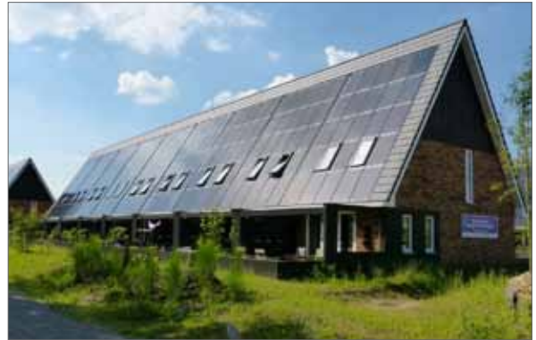
helder bouwvolume van één laag met kap
