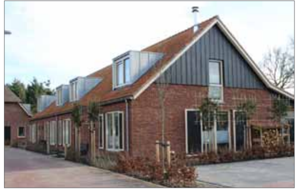
helder bouwvolume van één laag met kap
