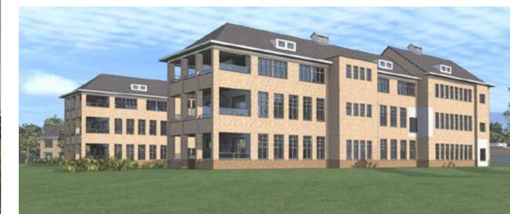
De oude loggia's worden hersteld. Balkons worden toegevoegd ter plaatse van de beschadiging.
