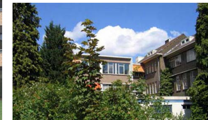
Huidige laagbouw tussen de beddenvleugels wordt gesloopt
