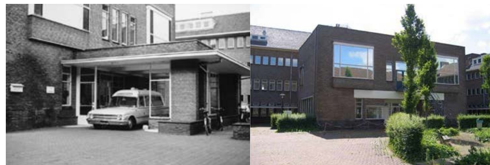
Te slopen voormalig opnamegebouw/operatiekamer op de binnenhof
