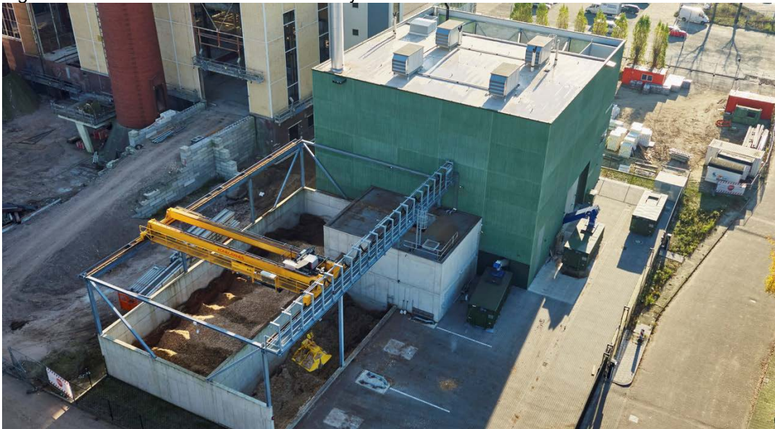
Figuur 1. Biomassacentrale van Ennatuurlijk in Eindhoven
