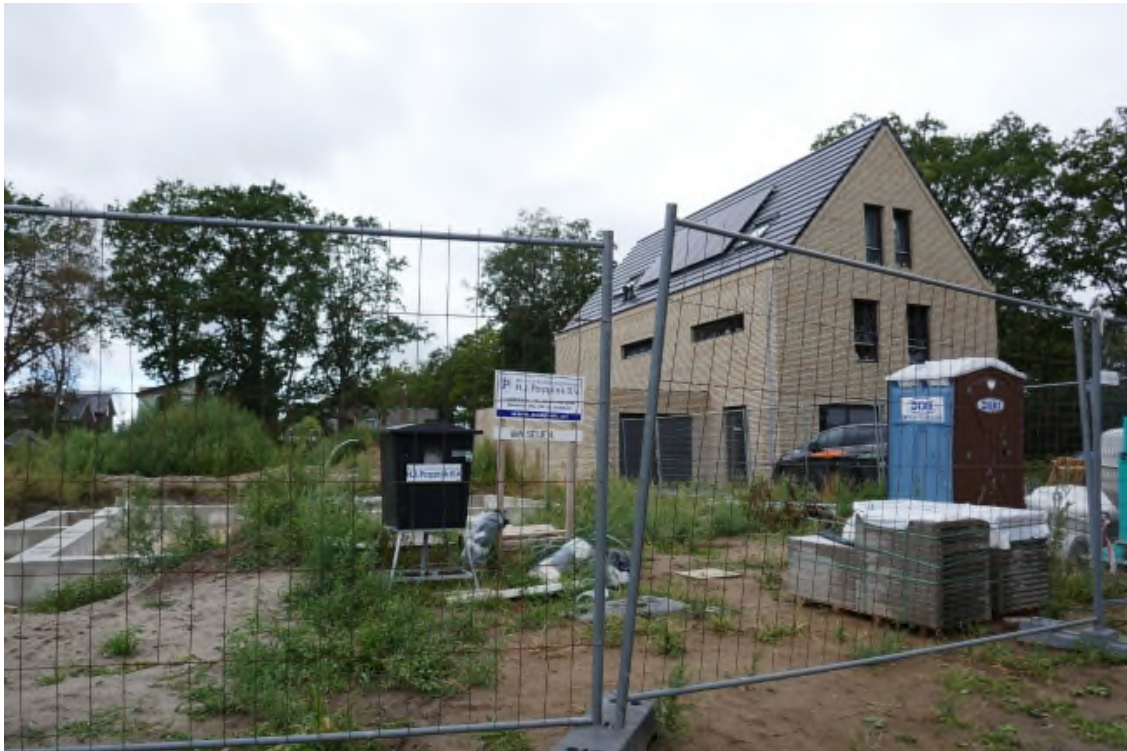
Bebouwing in blok 1 aan de Pieter Stuitjesstraat.
