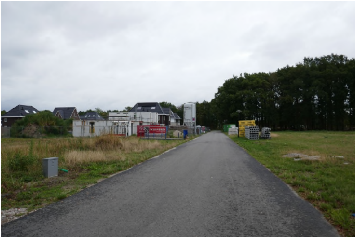
Bebouwing aan de Colenbranderstraat blok 6, gezien vanaf de andere zijde. Rechts blok 7.
