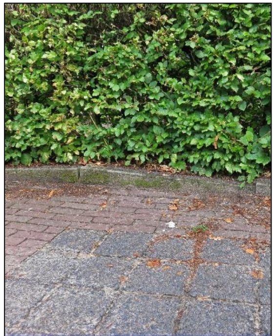
Figuur 5 Opdruk van een opsluitband door boom 5
