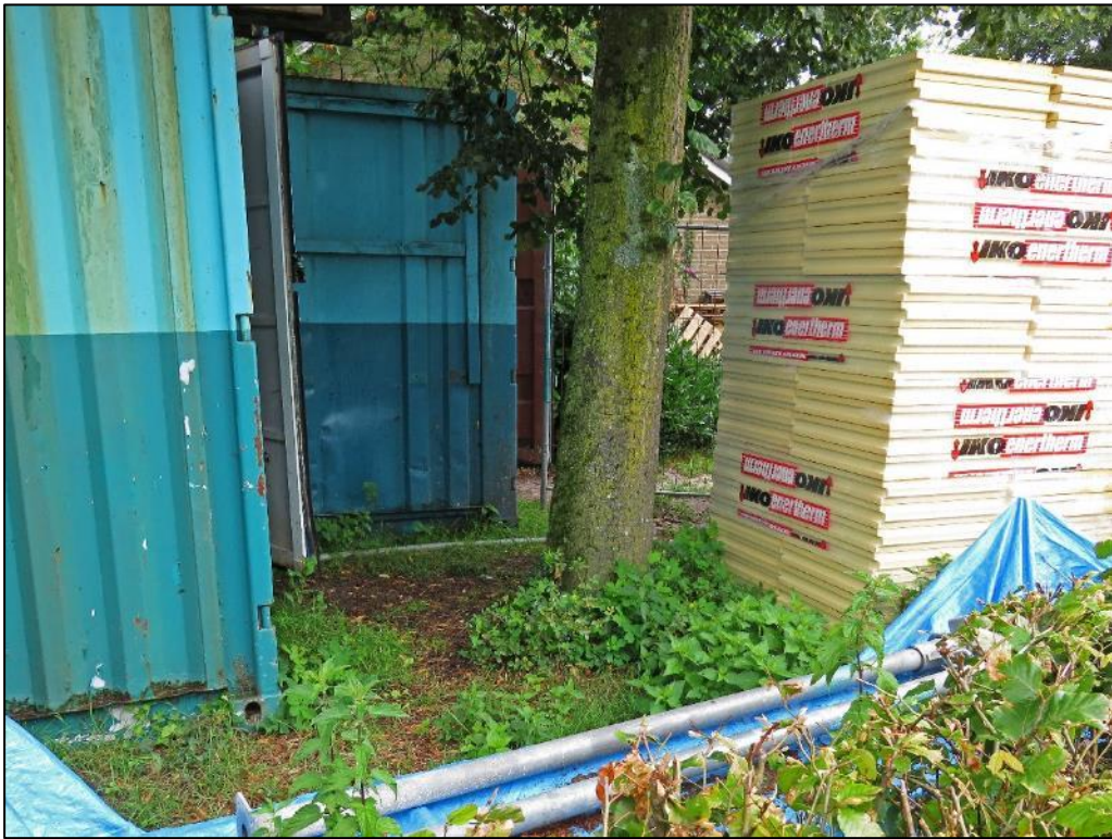
Figuur 6 Opslag van materialen rond boom 8
