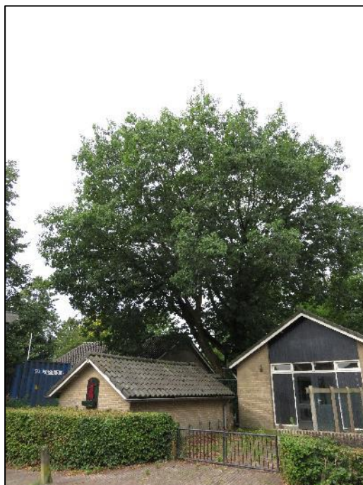
Figuur 13 Takken van boom 13 hangen op het te slopen gebouw
