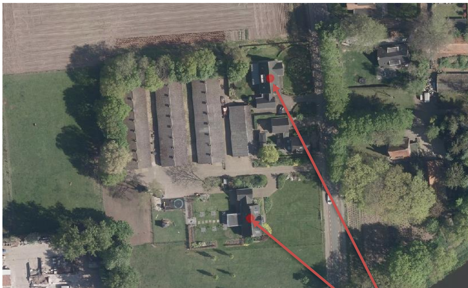
Figuur 1: Luchtfoto van de huidige situatie Gorsselseweg 16 en 12a
