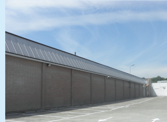
Hallen van de voormalige Aupingfabriek
