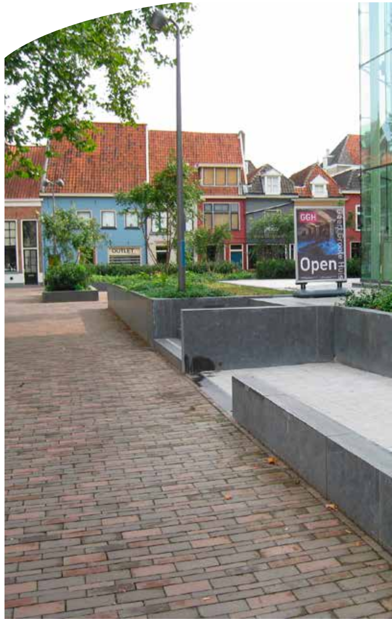
Waterpasseerbare verharding Lamme van Diesplein (2013)
