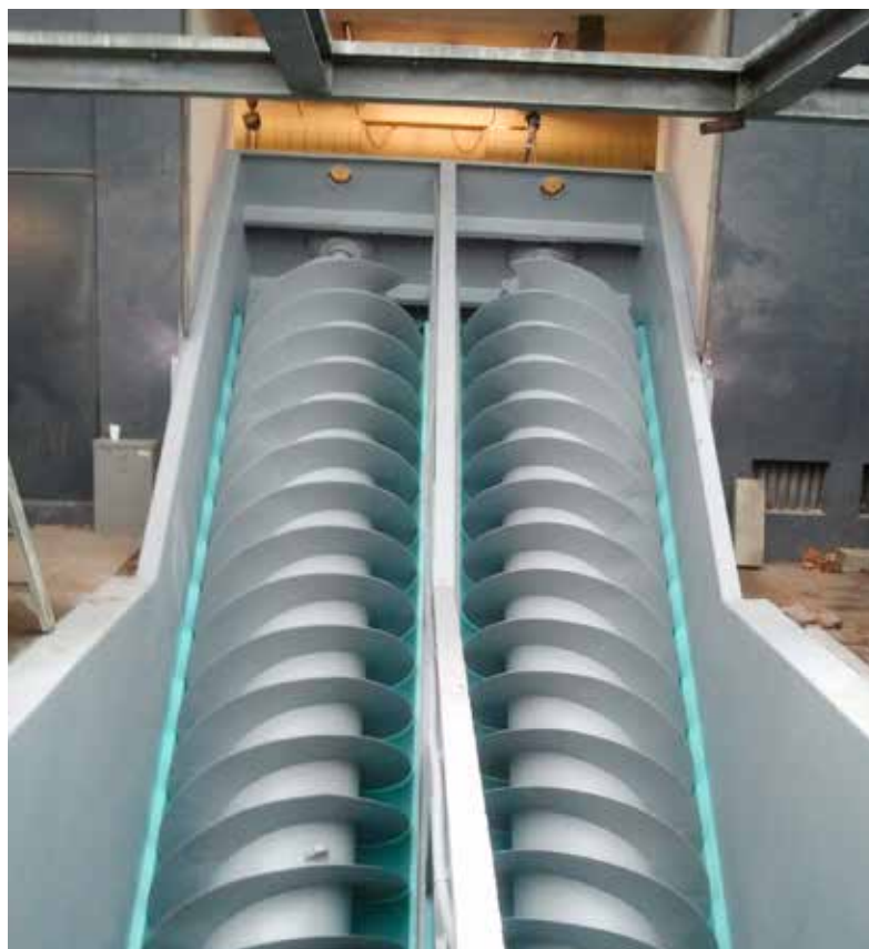
Groot onderhoud vijzelgemaal Pothoofd (2012)
