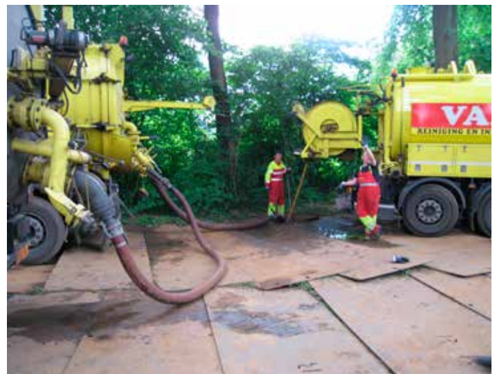
Inspectie stamriool Zandweerd (2014)
