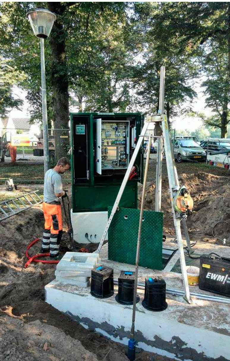
Vervanging gemaal De Worp (2014)
