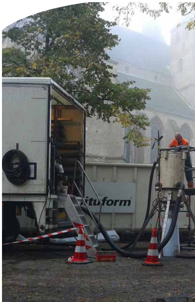
Relining riool Bergkerkplein (2014)
