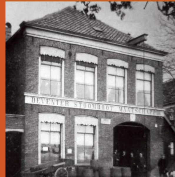
referentiebeelden en oorspronkelijk gevelbeeld van het te slopen DSM-pand naast de Panoramaflat
