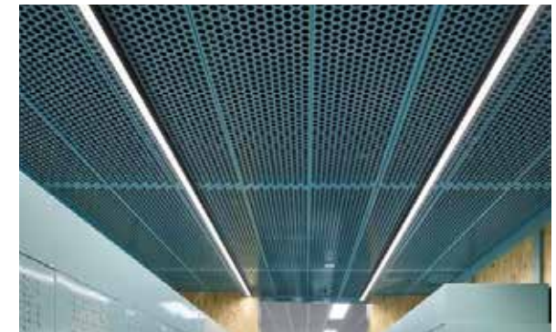
LED-verlichting tussen entree-afwerking
