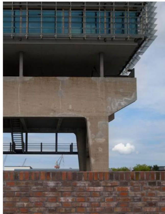
Voormalig kraanspoor, Amsterdam. Ontworpen door J.D. Postma. Betonnen constructie uit 1952 die werd gebruikt als platform voor twee hijskranen en als afbouwsteiger.
