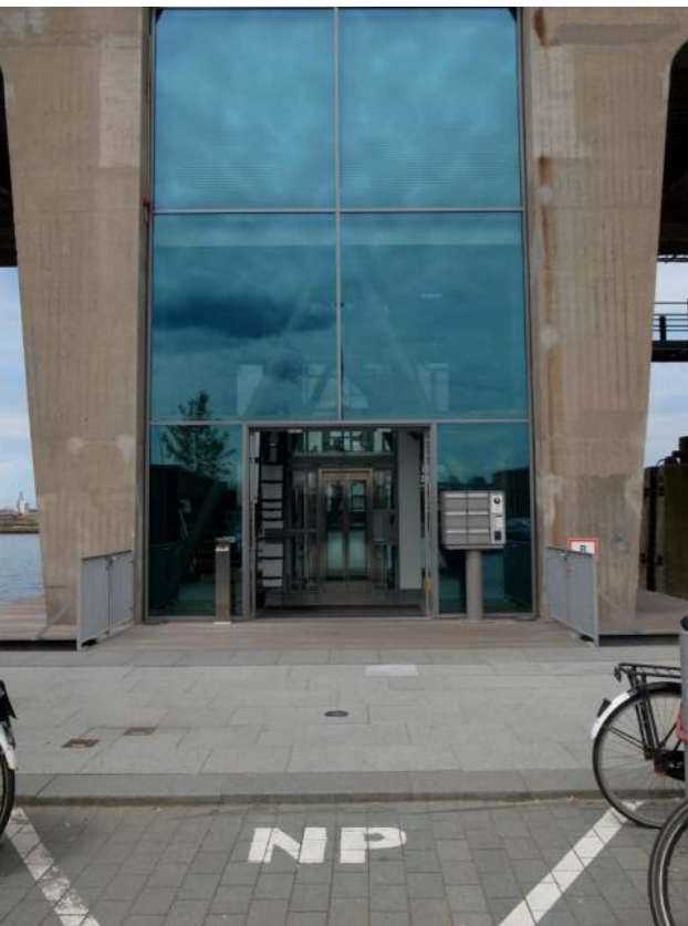
Voormalig kraanspoor, Amsterdam. Ontworpen door J.D. Postma. Betonnen constructie uit 1952 die werd gebruikt als platform voor twee hijskranen en als afbouwsteiger.
