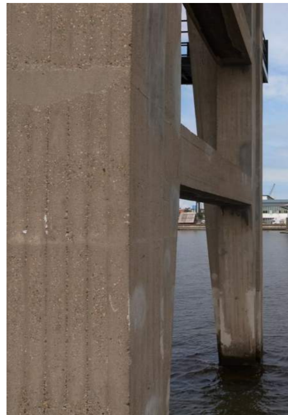
Voormalig kraanspoor, Amsterdam. Ontworpen door J.D. Postma. Betonnen constructie uit 1952 die werd gebruikt als platform voor twee hijskranen en als afbouwsteiger.
