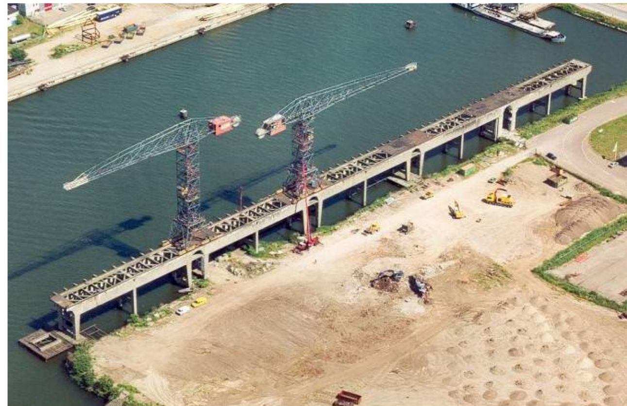
Voormalig kraanspoor, Amsterdam. Ontworpen door J.D. Postma. Betonnen constructie uit 1952 die werd gebruikt als platform voor twee hijskranen en als afbouwsteiger.
