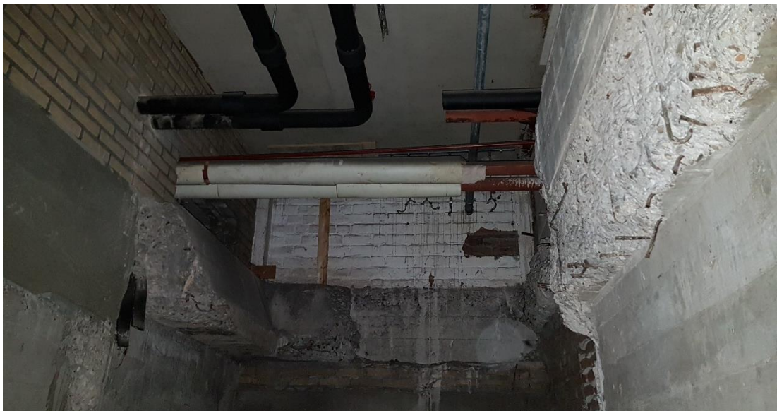
Foto 5. Situatie in de kelder van het gebouw
