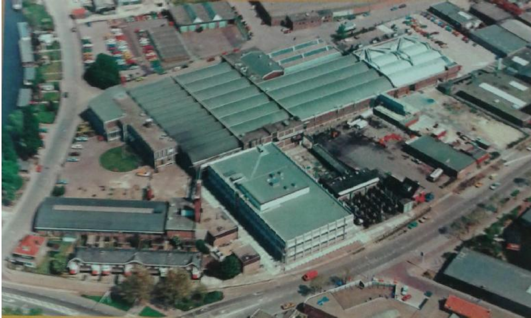
Afb.3.5 Overzicht 1981 met centraal op de voorgrond het nieuwe Reprogebouw
