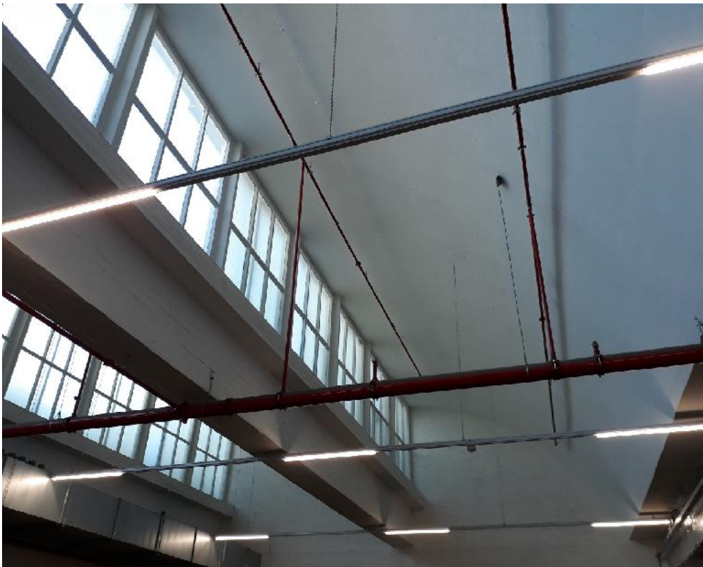
Afb.3.2 Betonnen sheddak van 'Gebouw 1951', gezien vanuit het interieur. De constructie is één betonnen geheel dat ter plaatse is gemaakt.
