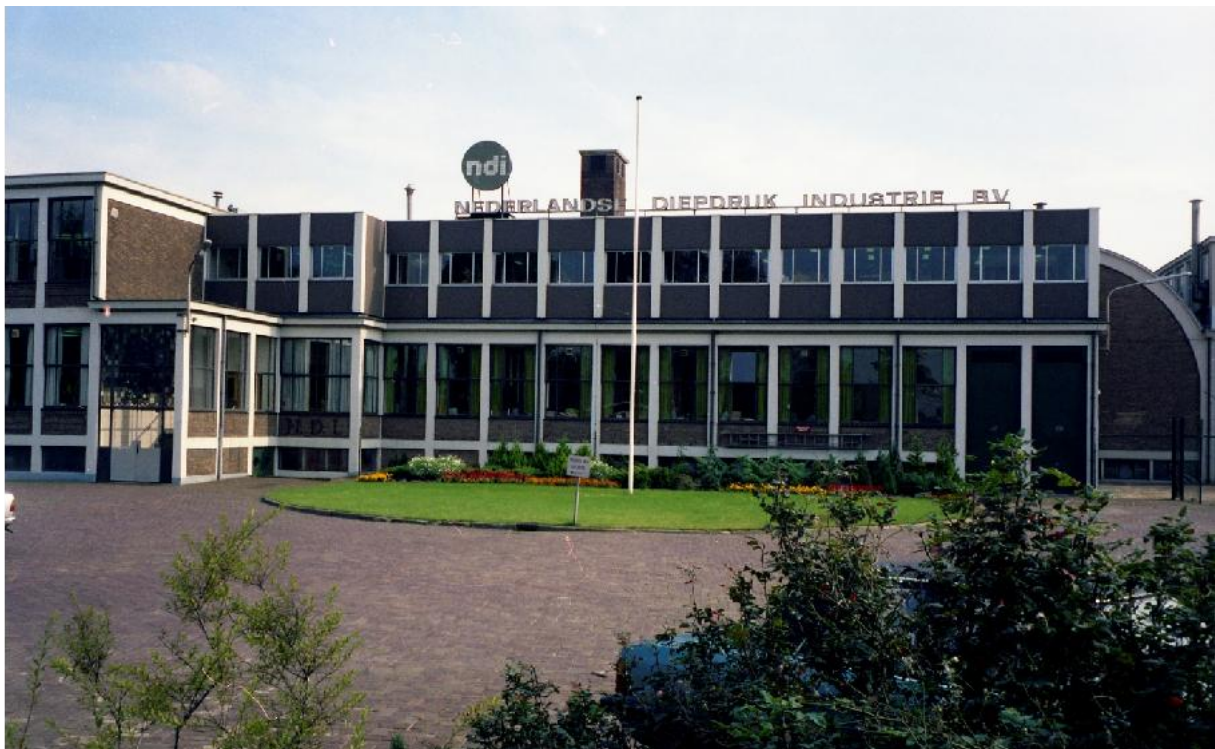
Afb.3.4 Zuidwest-gevel met entree van Gebouw 1951 na realisatie van de dakopbouw in 1973. De latere opbouw is goed te onderscheiden van het oorspronkelijke gebouw.
