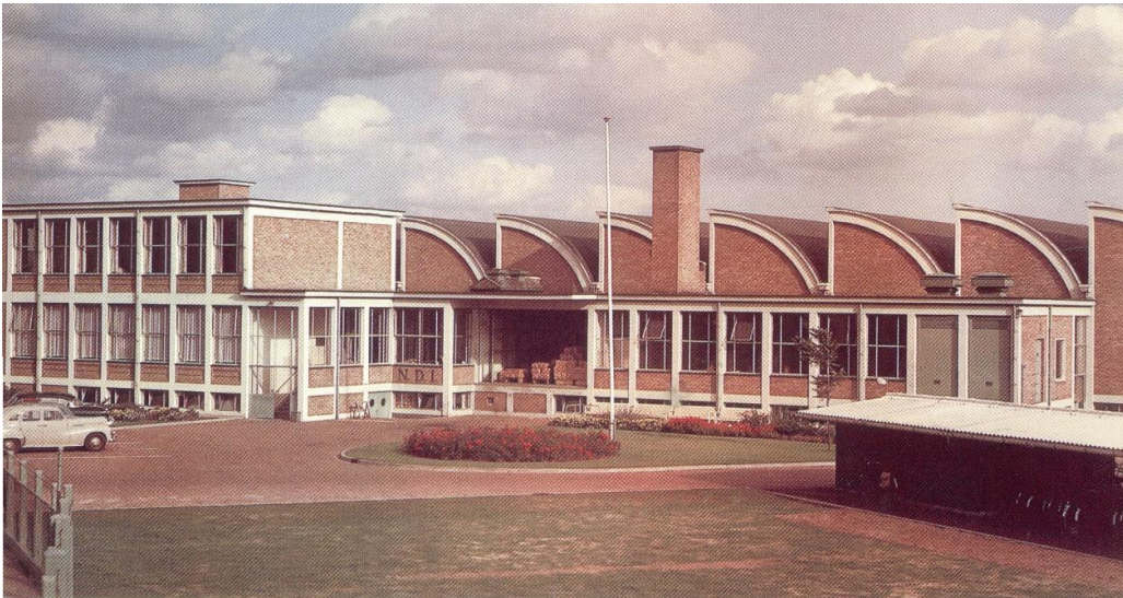
Afb. 3.1. Zijaanzicht van "Gebouw 1951"
