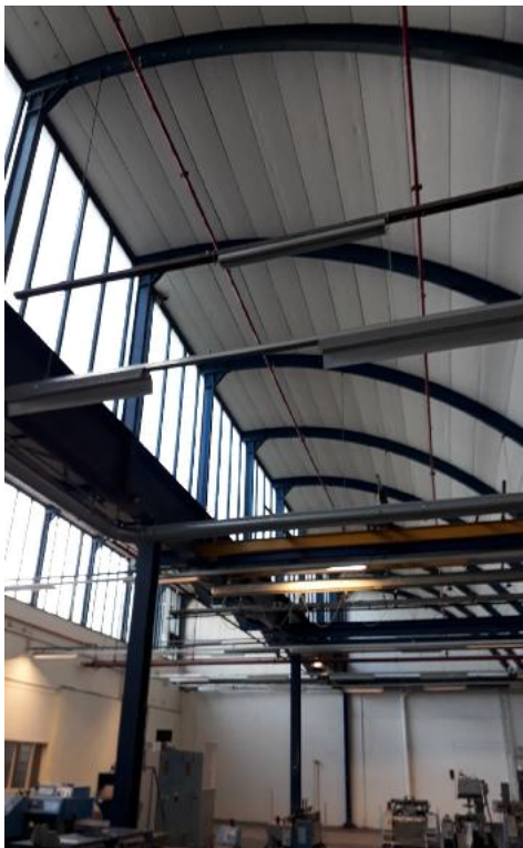
Afb.3.3 Sheddakconstructie van 'Gebouw 1956'. De dakspante en de ramen zijn eerst in contructie-staal opgebouwd waarna is het dak belegd is met losse gasbetonnen elementen.
