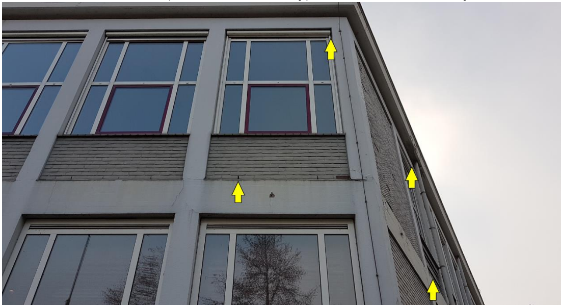
Foto 8. Voorbeelden van potentiële vlemuisverblijfplaatsen (hier in het gebouw bij de hoofdingang)
