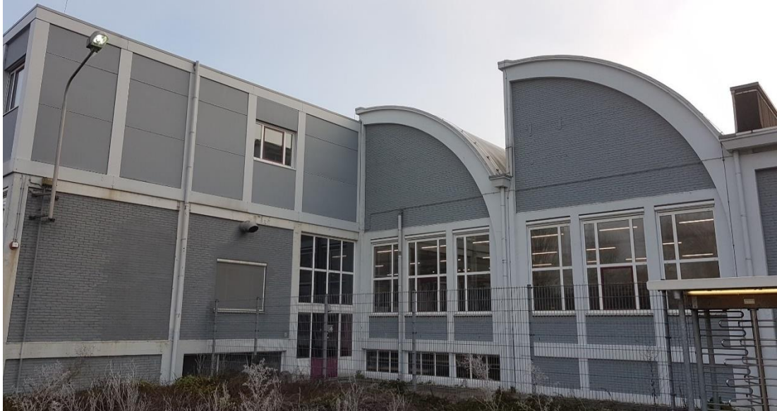
Foto 2. Gebouw met aluminium beplating (hier noordwestzijde)
