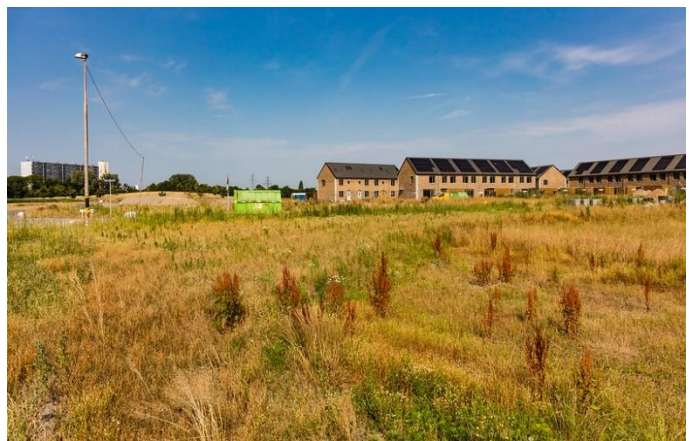
Figuur 10 Steenbrugge fase 1 in aanbouw
