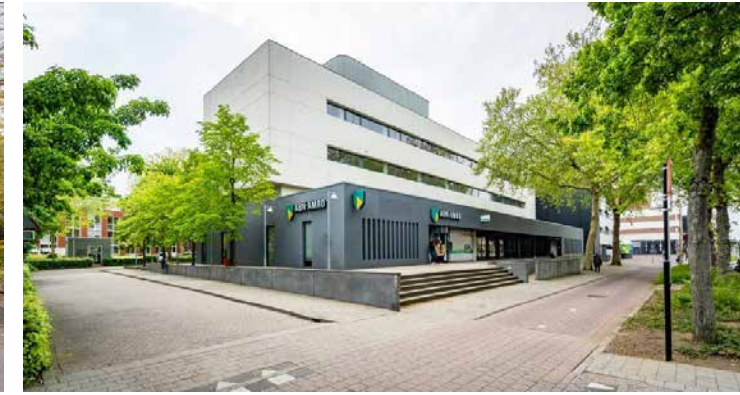
DE ABN AMRO BANK UIT 1975, H.A. MAASKANT
