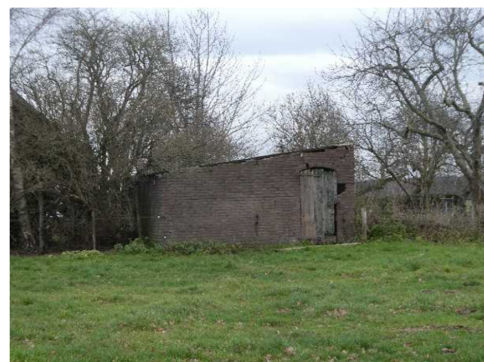
Bestaande situatie schuur in de voortuin
