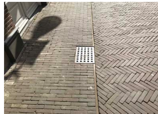
Overgang straatwerkverbanden, foto: Vleeshouwerstraat
