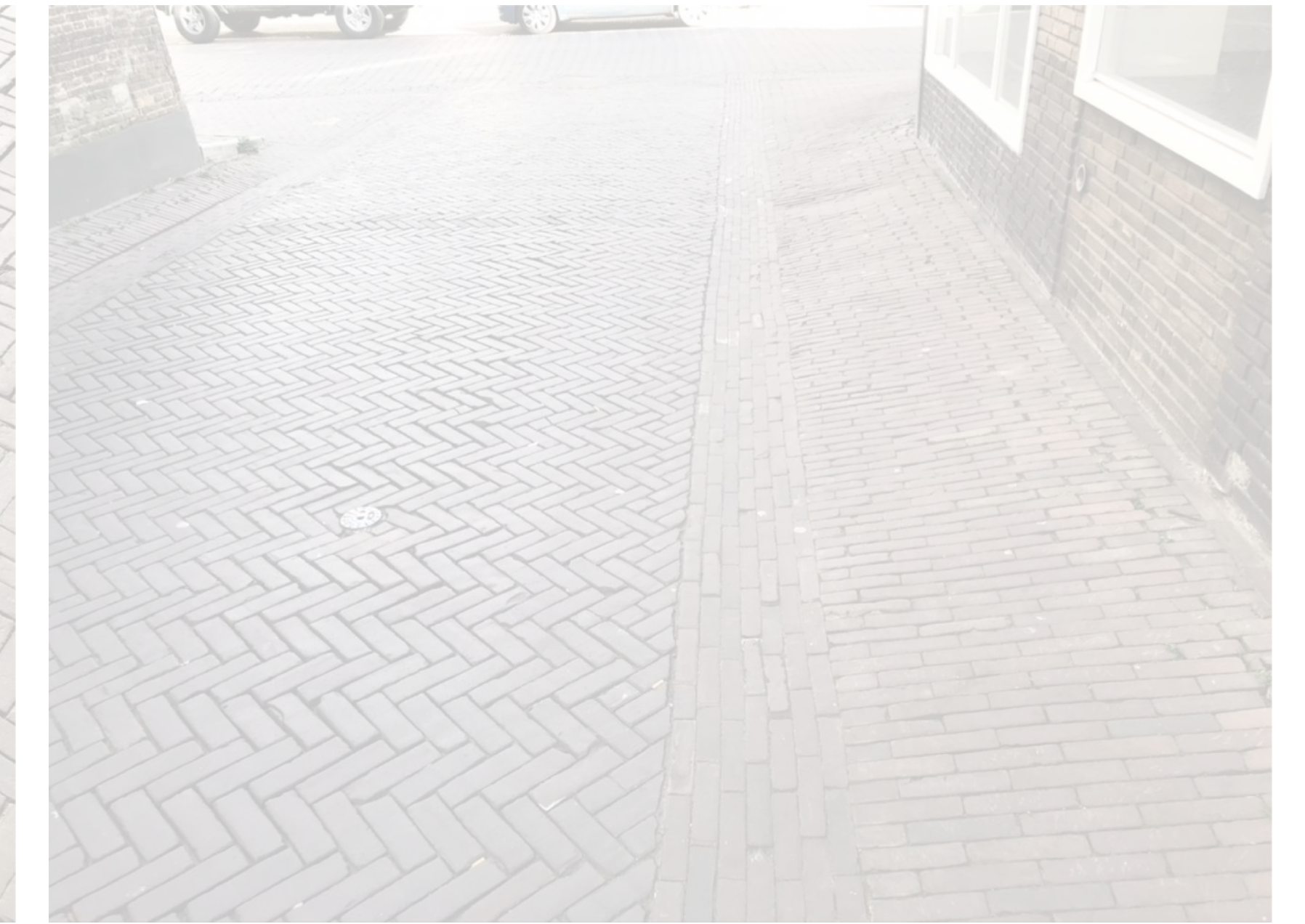
Molpoot in straatwerk t.b.v. afwatering en als scheiding foto Boterstraat
