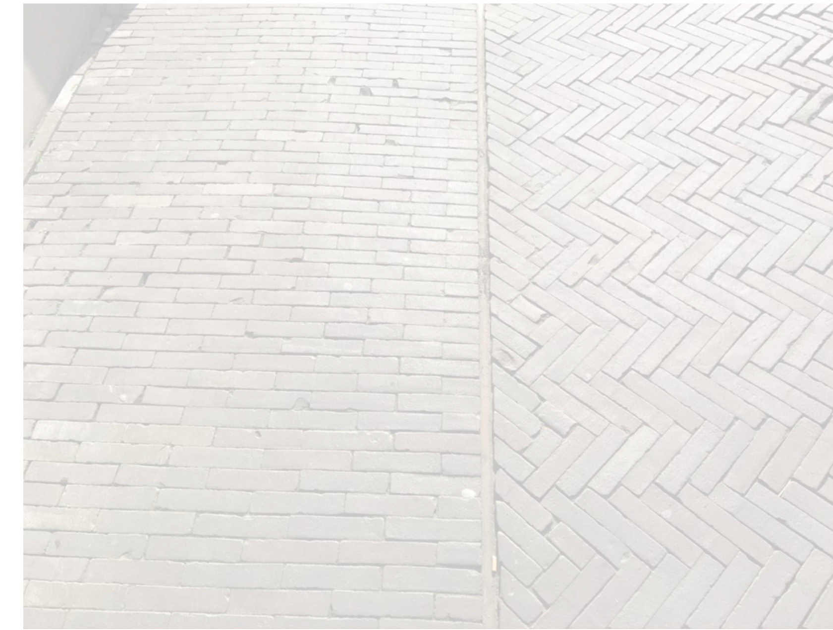
Overgang straatwerkverbanden foto Vleeshouwerstraat
