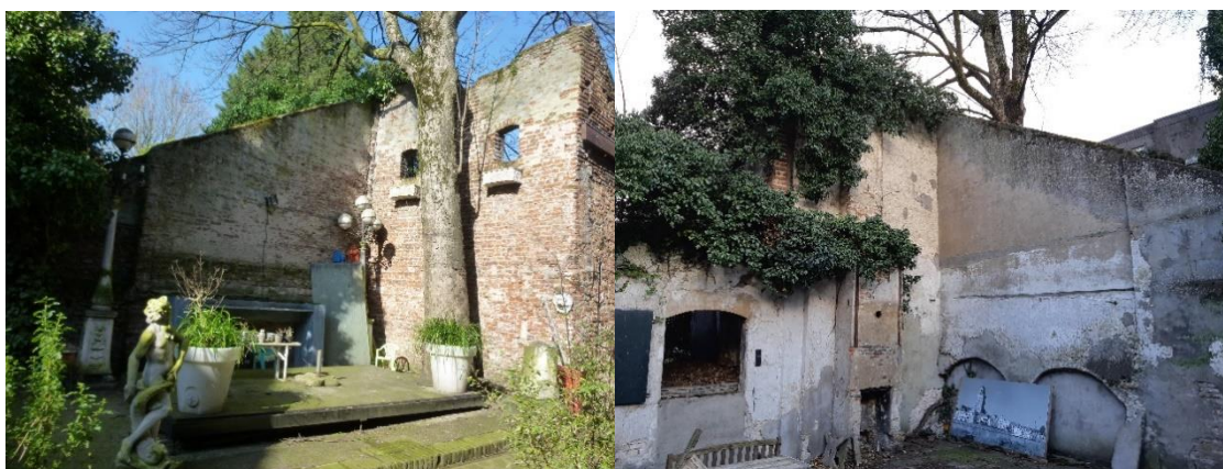
Figuur 13: Foto's oude muren Grote Overstraat 29-33-35
