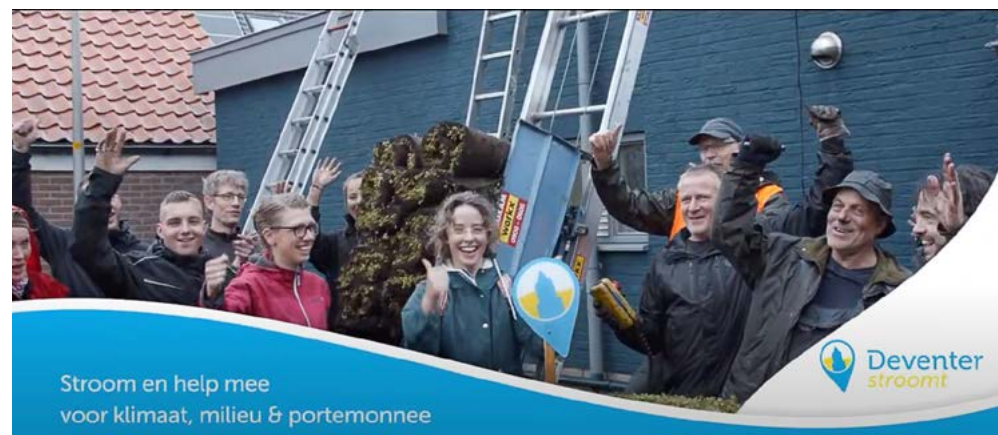
Afbeelding 2: aanleg groenen daken door bewoners van de Hoven.
