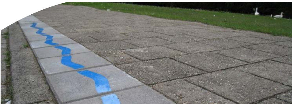
Afbeelding 17: 'Golftegel' wordt toegepast om het trottoir te verlagen op plekken waar regenwater vanaf de weg het groen kan inlopen om daarmee wateroverlast te voorkomen en verdroging van het groen tegen te gaan.
