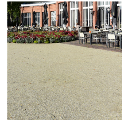
Halfverharding, special Type: padvast Leverancier: Infranology waterdoorlatende pleinverharding, opgebouwd uit een onderlaag (grove fractie 0-14) en een toplaag (fijne fractie 0-6)
