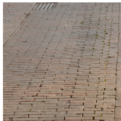
Pleinverharding loopstrook halfsteensverband gebakken klinker, waalformaat
