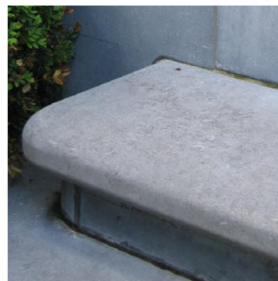
Bordes bij bibliotheek Natuursteen, Belgisch hardsteen, Leverancier: Carrieres du hainaut afwerking geschuurd (licht grijs), tegels 90x90cm Uitgaande van hele tegels, zaagwerk minimaliseren
