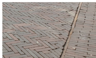
Staalstrip Scheiding tussen verhardingen, afschotknip, boomspiegel Stromarkt en opsluiting verhardingen bij plantvakken. Corten staalrand type Deventer, uitvoering gelijk aan winkelstraat. Zie ook detail uitwerking en profiel 6,7,8,9
