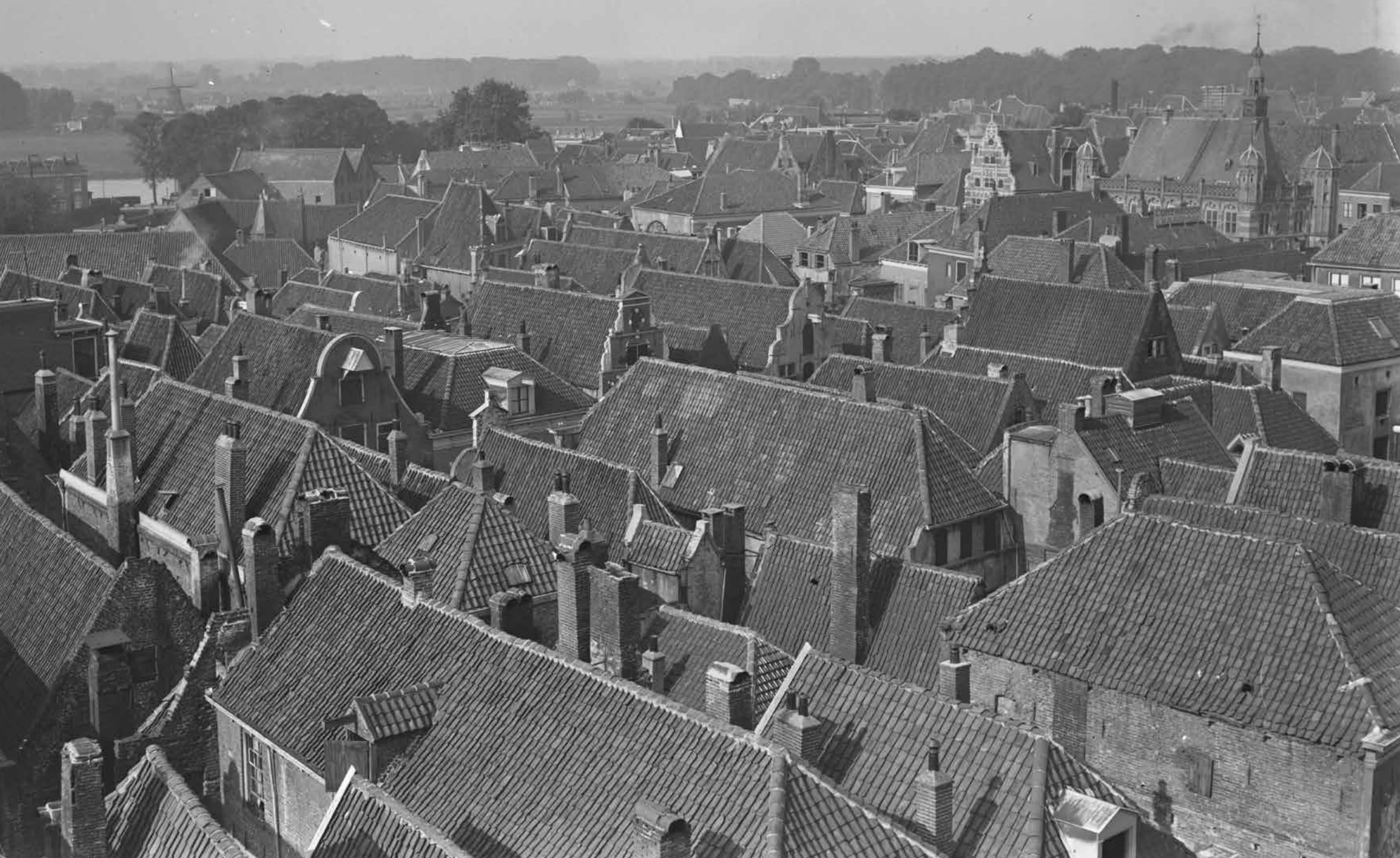
Het Deventer daklandschap vanaf de Bergkerk, rechts de Waag en op de achtergrond de overkant van de IJssel. Glasegatievencollectie J.W. Jansen, 1900-1930. [Stadsarchief Deventer]
