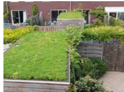
groen dak op berging extensief
