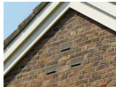
inbouwkast vleermuizen
