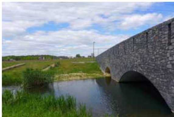
De nieuwe Steenen Brug over de Zandwetering naar Steenbrugge anno 2020
