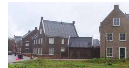
hoek met garage als huisje en tuinmuur
